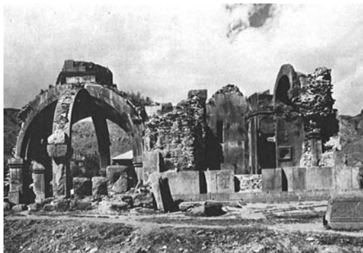
Figura 9 Monasterio de Arates (Cuneo 1988). A la izquierda se puede observar lo que queda del gavit
