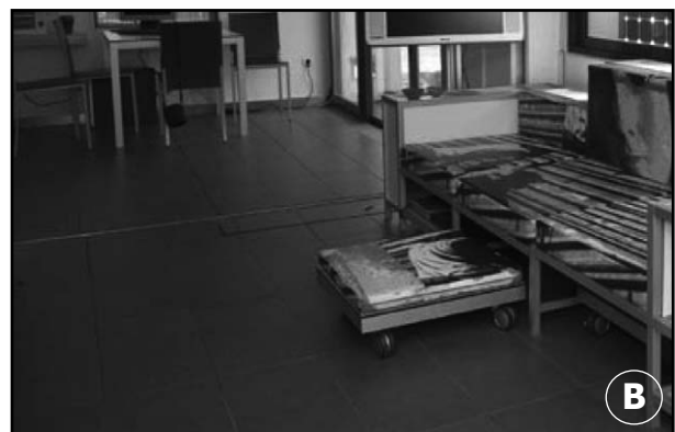
Figura 4. (A) Baldosa de pavimento vista por abajo, con el contenedor metálico y los orificios de llenado, y por arriba, colocada en la vivienda (B).
