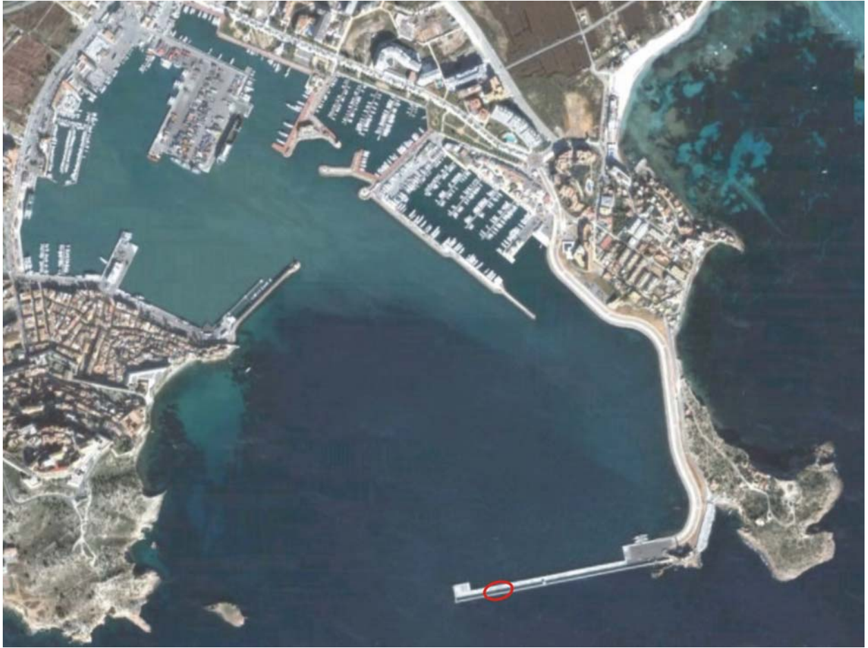
Figura 0. Situación del cajón instrumentado en el Dique de Botafoc (A.P de Ibiza).
