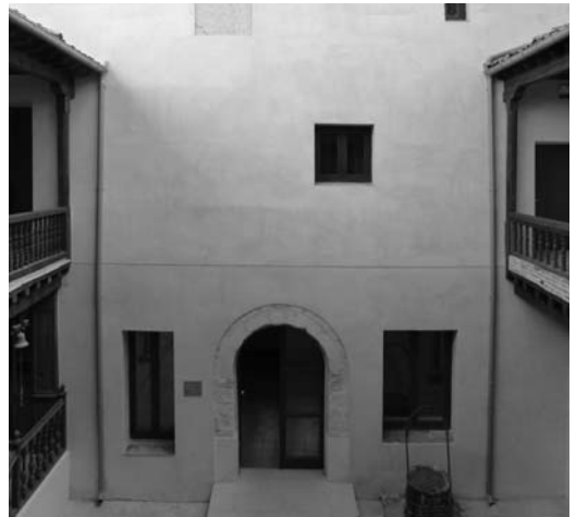
Figura 8 Fotografía rectificada del alzado sur del patio
