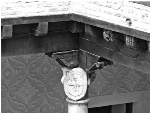
Figura 9 Fotografía de un rincón del patio en el que se observan piezas de madera de distintas intervenciones
