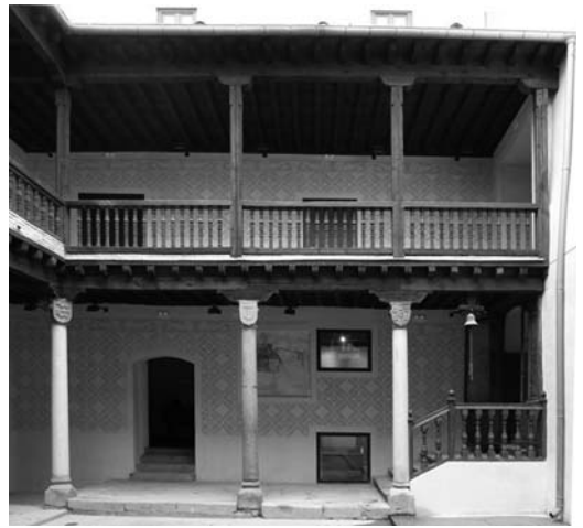
Figura 7 Fotografía rectificada del alzado este del patio
