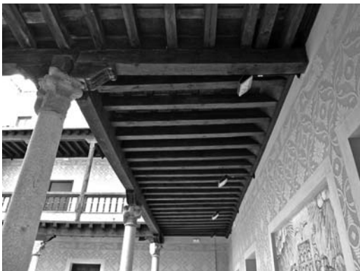
Figura 3 Fotografía del forjado de la galería
