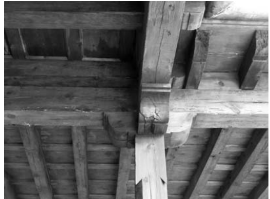
Figura 10 Forjado de madera sustituida en el nivel superior de la galería
