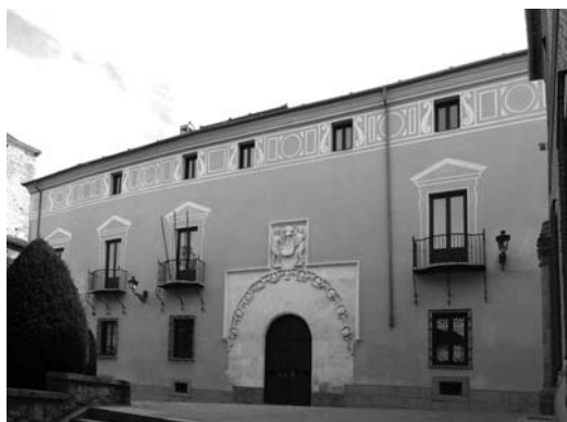
Figura 1 Fachada principal del Palacio Quintanar
