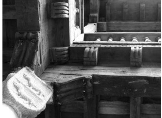
Figura 4 Fotografía de la superposición de materiales en la galería del patio
