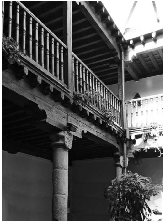
Figura 13 Fotografías del patio del Palacio de Mansilla. Galería superior abierta
