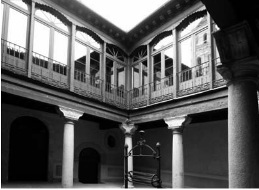
Figura 11 Palacio del Marquesado de Lozoya o Casa del regidor López de Losa
