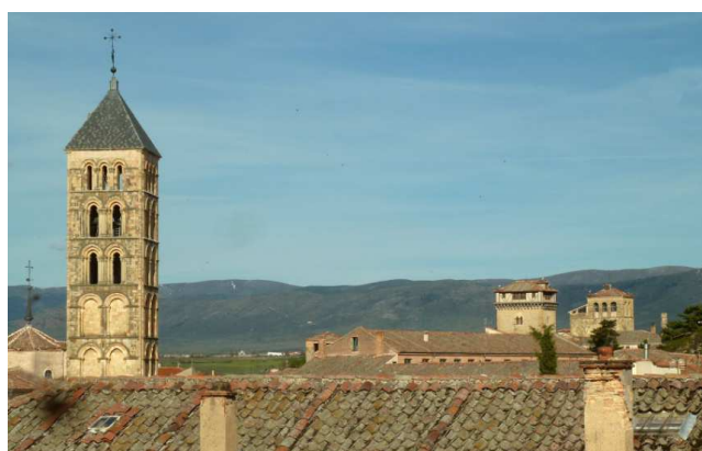
Fig. 7. Fotografía realizada por encima de las cubiertas que permite disfrutar de la silueta urbana de las torres.
