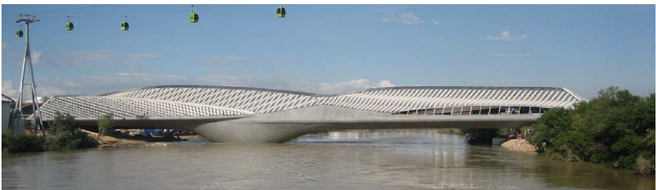
Fig.5 Vista del puente terminado desde aguas arriba.
