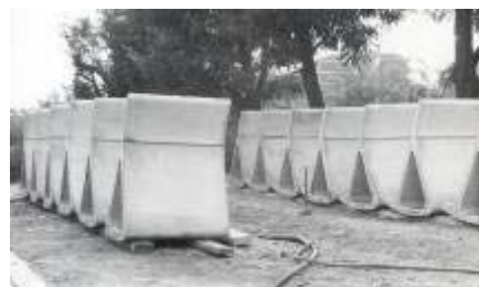
Dovelas del Centro de Estudios Hidrográficos (1961)
