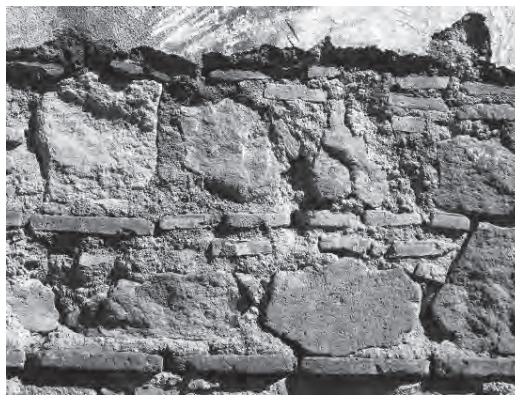
Figura 6 Mampostería encintada en el muro norte. Imagen del autor
