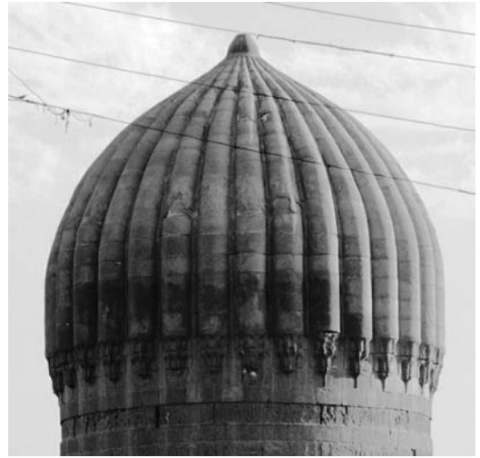
Figura 1 Cúpula sobre un mausoleo de la necrópolis Sur del Cairo adornada exteriormente con nervios semicilíndricos radiales, construida en piedra con sillares en voladizo de lechos horizontales (foto del autor 2013)
