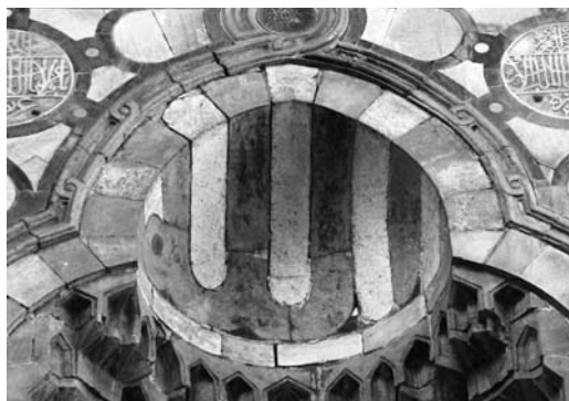
Figura 8 Nicho formado por dos aparejos de dovelas girando alrededor del eje horizontal enfrentados entre sí. Las franjas verticales permiten escribir el nombre de Alá (foto del autor 2013)
