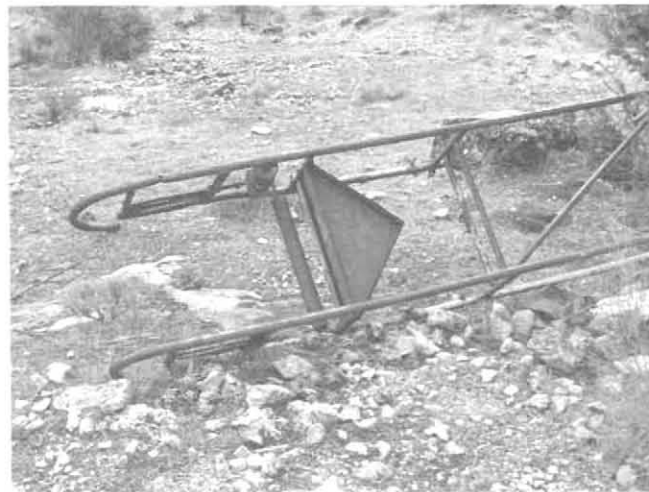
Fig.-9.-Restos del armazón de una cinta transportadora
