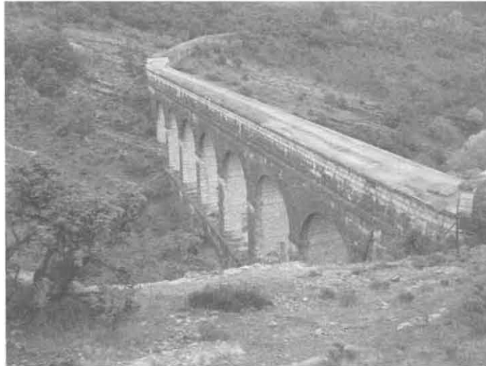
Fig.-3.-Acueducto del Canal de Isabel II
