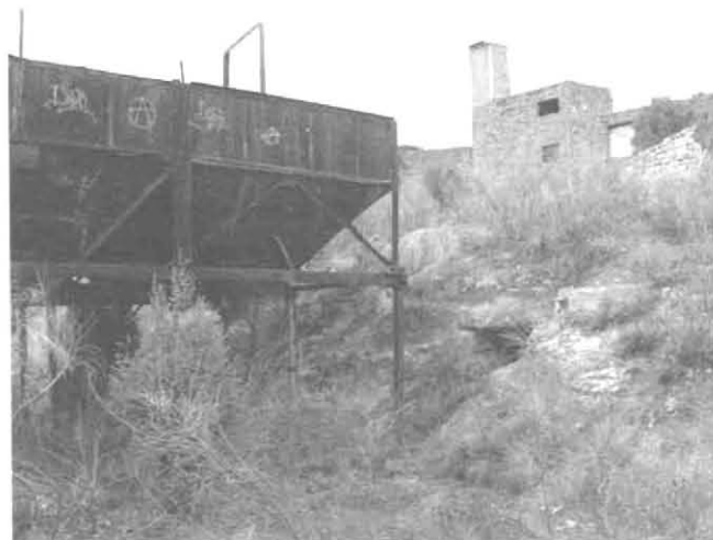
Fig.-10.-Vista de las instalaciones desde las tolvas
