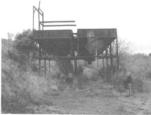
Fig.-5.-Conjunto de tolvas
