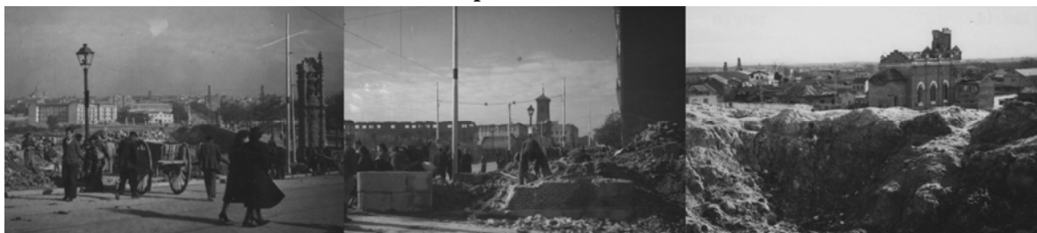
Figura III Destrucciones y labores de desescombro en la zona del Puente de Toledo, en la zona sur de Madrid, tras el final de la Guerra Civil Española en 1939.
