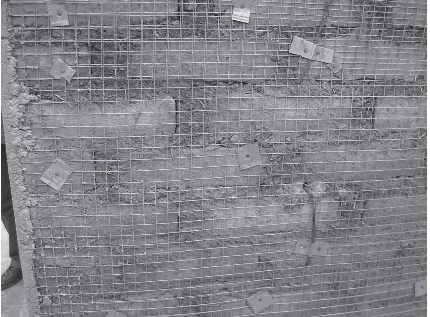
Fig.12: Mallas metálicas para refuerzo de muros de tierra. (Foto: P. Hurtado Valdez).
