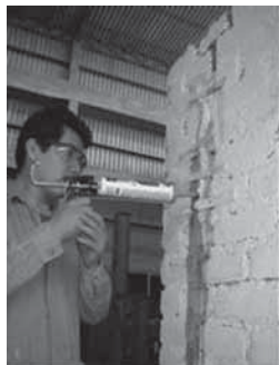
Fig.10: Inyección de mortero en grietas. (Foto: D. Torrealva, s.f.).
