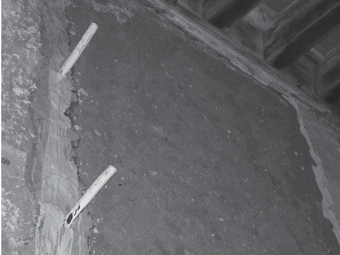
Fig.9. Boquillas para la inyección de mortero. (Foto: P. Hurtado Valdez).
