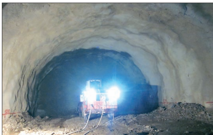
[Figura 5].- Perforación a sección completa del túnel Frijolar Nuevo.
