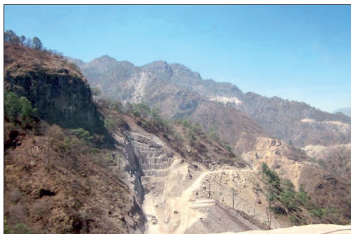
[Figura 4].- Portal Durango del túnel Frijolar Nuevo.
