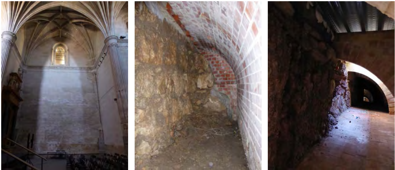
Figura 13. a) Iglesia de Santa Cruz la Real de Segovia, cara interior del muro sur (abril 2016); b) Cámara de aireación de la iglesia de San Pablo en Valladolid (febrero 2016); c) Cámara de aireación de la iglesia parroquial de Vall de Almonacid en Castellón (octubre 2015).
