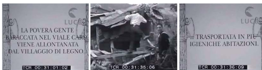
FIG. 2/ Demoliciones de barracche , chabolas que inundaban el centro y la periferia romanas, y traslado de sus habitantes a las nuevas promociones de viviendas de la periferia sin considerar ningún criterio de afectación para los desplazados.
