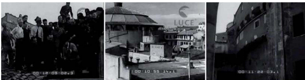
FIG. 1/ Mussolini con el piccone demolitore , participando en los trabajos de demolición del tejido residencial que ocultaba el Mausoleo de Augusto, usado como auditorio.
