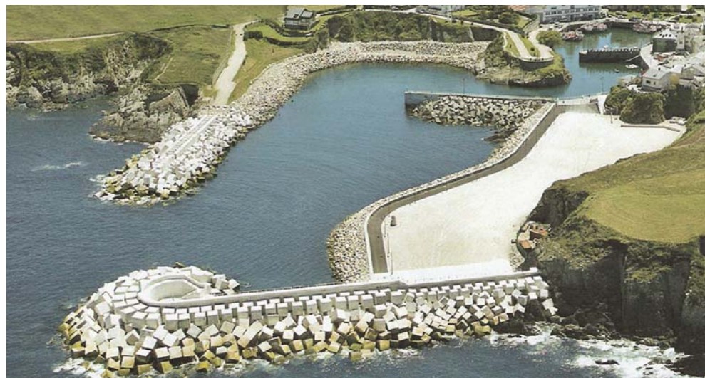
Figura 2. Ampliación del Dique de Puerto Vega, Asturias
