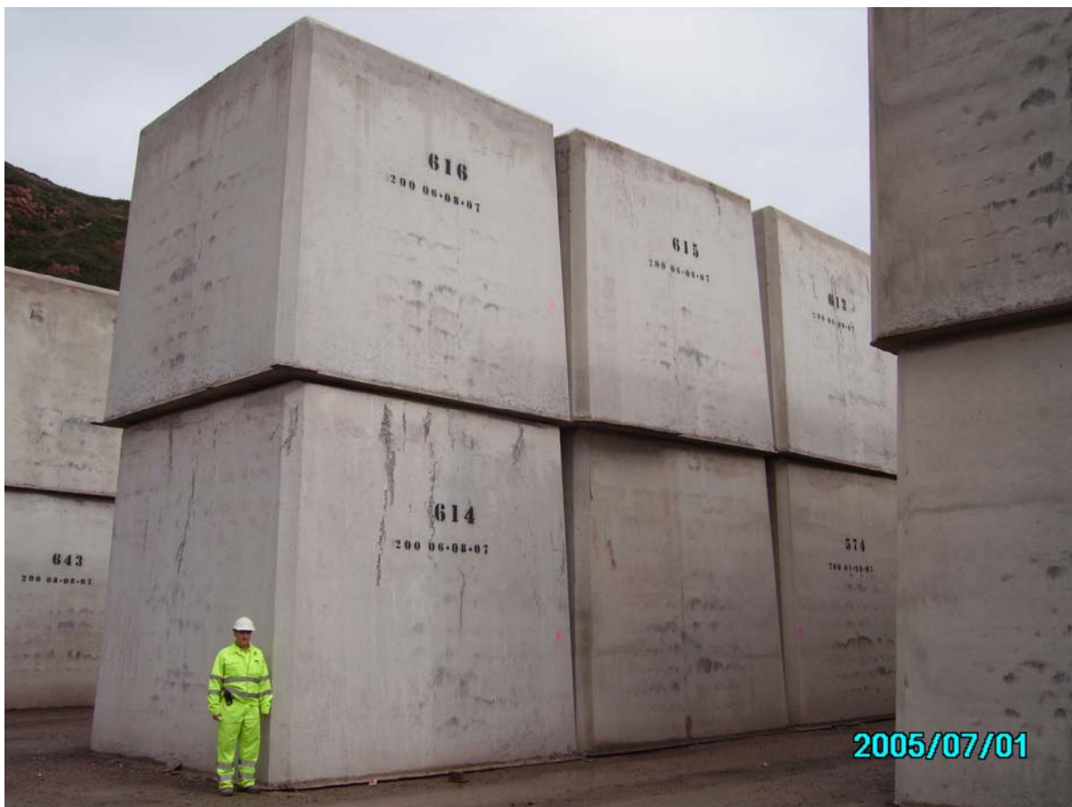
Figura 7. Bloque de 200 t en Cabo Torres, Gijón ( D_{n50} = 4.40 m)
