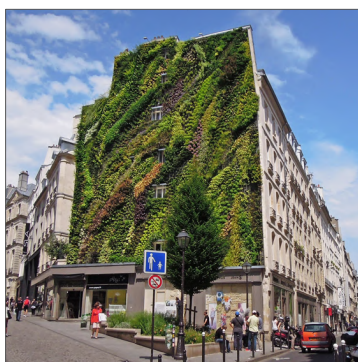
fig 4. Fachada verde en medianera
