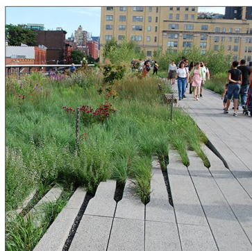
fig 1. Pavimento de hormigón permeable
