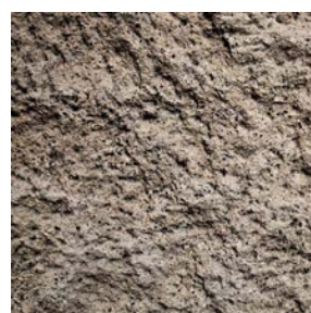
3.57 Detalle tratamiento hormigón I
