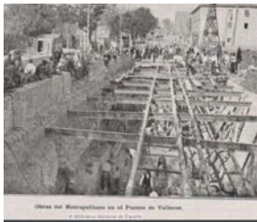
1.13. Obras del Metropolitano en Puente de Vallecas
