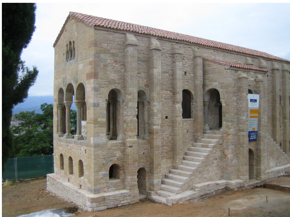
2.27. Estado de Santa María de Naranco durante las obras de 2005. Fotografía cedida por Milagros Palma Crespo.
