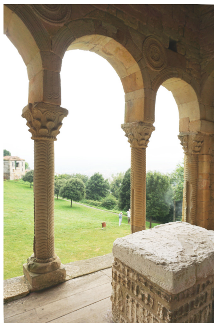
2.16. Vista exterior desde el Sureste, donde puede observarse la restitución completa del atrio Este, y los restos sin recuperar del pórtico Sur.
