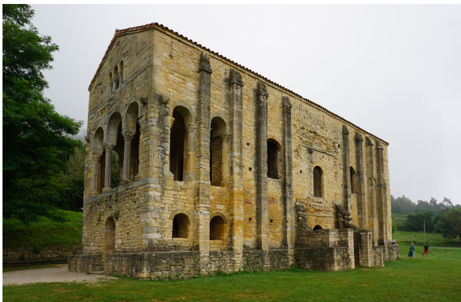
2.30. Situación actual del monumento. Vista desde el Suroeste.
