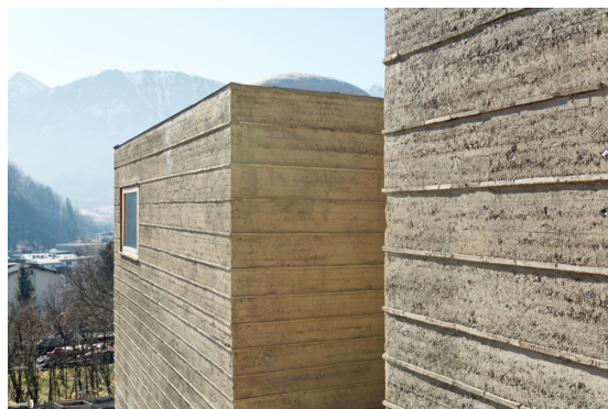
Fig 57 y 58 : Muros de tie- rra apisonada de la cons- tructora LehmTonErde
