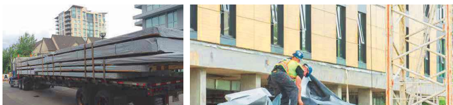
Fig 1.14. Prefabricación de los paneles de fachada
