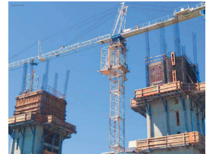
Fig. 1.6. Encofrado núcleos de hormigón
