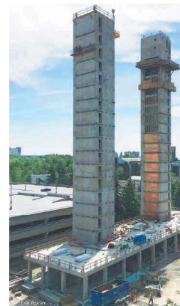
Fig 1.1 Estructura de hormigón
