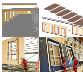
Fig. 2.5. Montaje de elementos de borde
