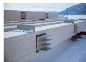
Fig.3.4. Recepción en obra de pilares de tres plantas.
