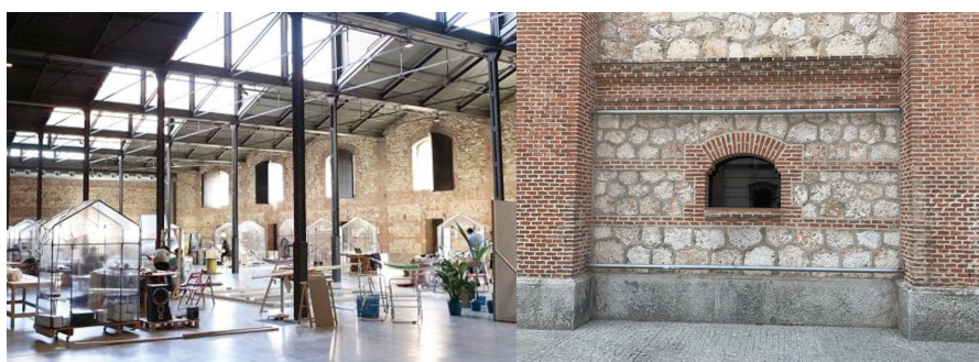
3.165. (a la dcha.) Detalle de fachada exterior.
