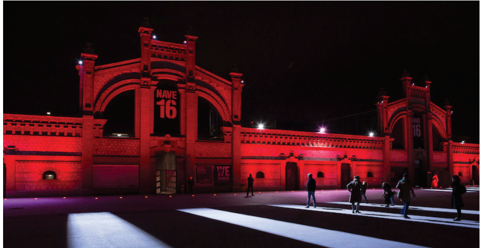
3.181. Iluminación nocturna del complejo.
