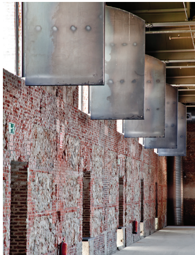
3.182. (a la izq.) Detalle de fachada de ladrillo visto.
