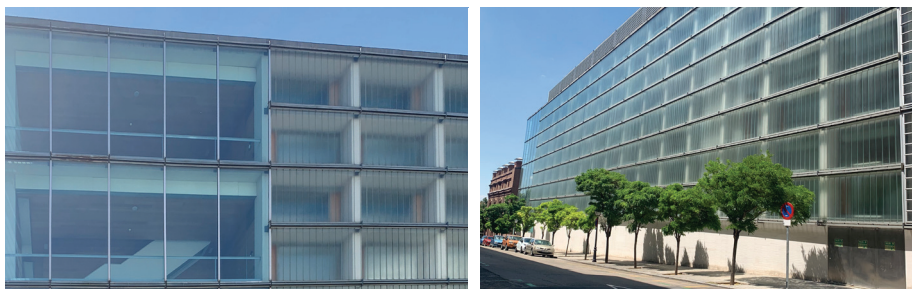
3.122. (a la izq.) Cerramiento de cristal y cerramiento de U-Glass en la fachada de la calle Bustamante.
