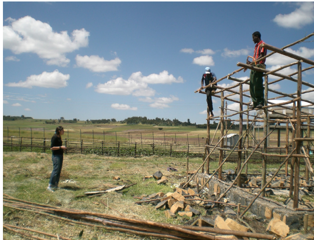
Figura 21: Estancia de Sala de Estar y dormitorio en proceso de construcción
