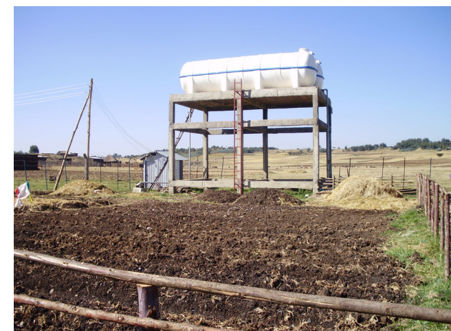
Figura 12: Depósito de agua para el riego por goteo.
