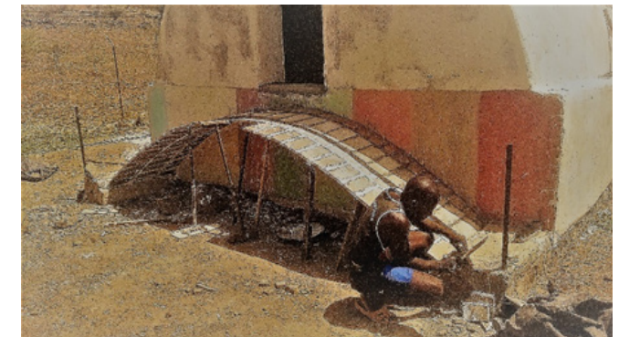
Figura 36: Fabricación de una cúpula de ladrillo de arcilla Fuente: Fotografía de Pablo Moñino en Turkana, Kenia
