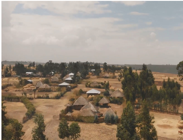
Figura 25: Vista aérea de varios conjuntos de viviendas separados Fuente: archivo fotográfico MCSPA
