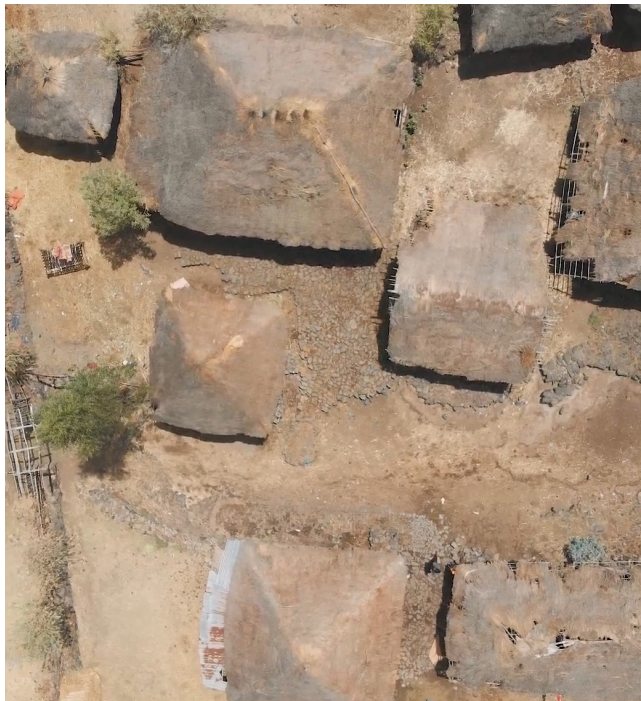
Figura 26: Vista aérea de una unidad de vivienda cercada con diferentes elementos Fuente: archivo fotográfico MCSPA
