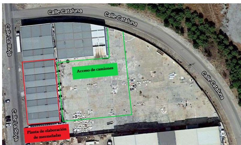
Figura 1. Nave seleccionada y acceso de camiones
