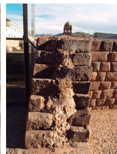
Fig. 3.308 Relleno muros (Autor)
