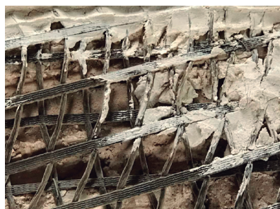
Fig. 3.325 Malla de refuerzo, Bam (Autor)
