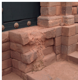
Fig. 3.307 Relleno muro Cusco (Autor)
