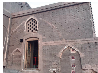
Fig. 3.326 Malla refuerzo, Bam (Autor)
