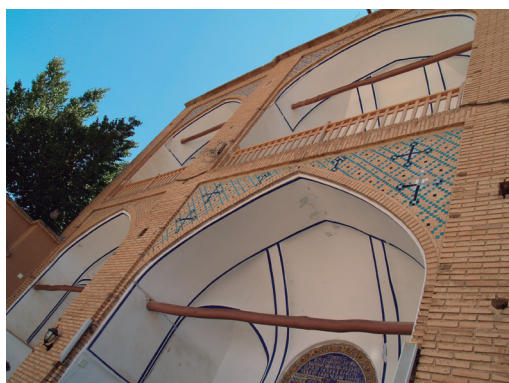
Fig. 3.342 Iglesia de Belén (Autor)
