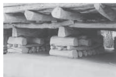
Fig. 3.289 Entramado de madera, Lahijan (A.Naderzadeh)
