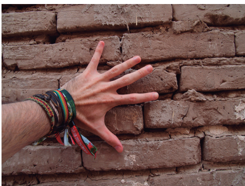
Fig. 3.363 Fábricas de ladrillo de Bam (Autor)
