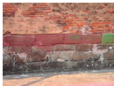
Fig. 3.292 Zócalo de arranque de muro (A.Naqi)
