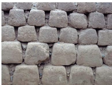
Fig. 3.354 Juntas trapezoidales, Chan Chan (Autor)
