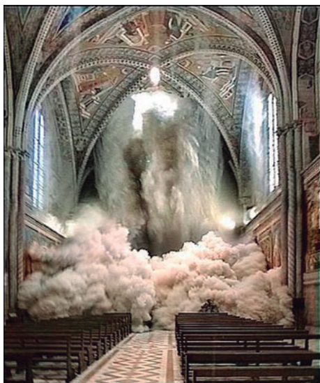
Fig. A.63 Colapso bóveda S.Francisco de Asís (Umbria Journal)
