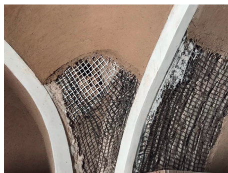
Fig.A.79 Malla de refuerzo, Bam (Autor)
