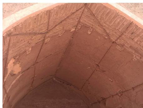
Fig.A.82 Atado de bóveda con cuerdas (Autor)
