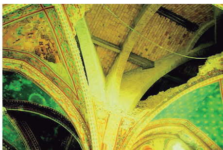
Fig. A.65 Cubierta Basílica de S.Francisco de Asís (G.Croci)
