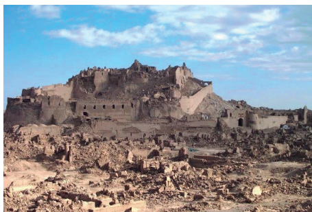
Fig. A.69 Bam después del terremoto (Manafpour)
