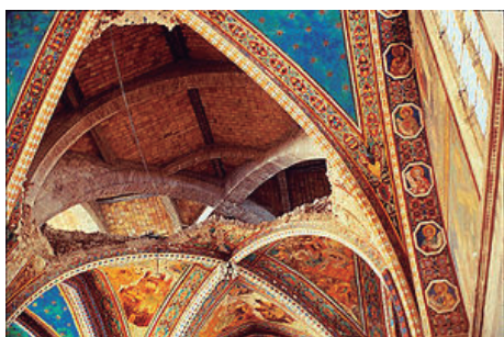
Fig. A.64 Bóveda de San Francisco de Asís (Sebasgs)
