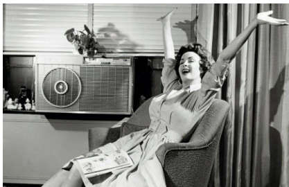
Carrier Air Conditioning Company of America nació con el objetivo de satisfacer la demanda de mayor productividad en los lugares de trabajo. Hoy Carrier Corporation es el mayor fabricante y comercializador de aire acondicionado
