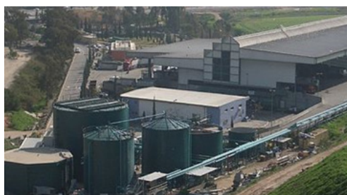
Img. 7.9. Instalación de biomasa
