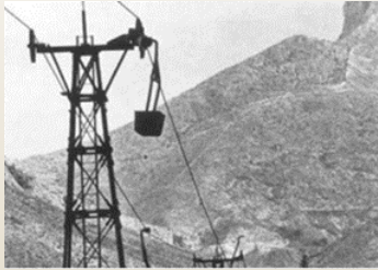
Aerial cable of the Sierra Minera Cable aéreo de la Sierra Minera https://www.imagenescartagena.es
