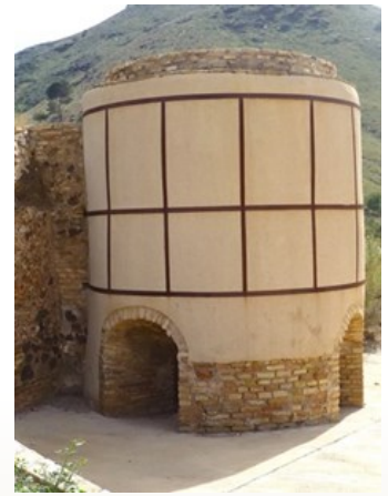
Roasting and calcining Oven Horno de tostación y calcinación Luis Miguel Villar Angulo. https://lumivian.es/
