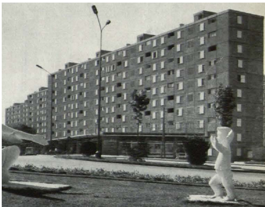
4.8 Fachada del bloque de viviendas prefabricadas en Moratalaz (Madrid, 1964)
