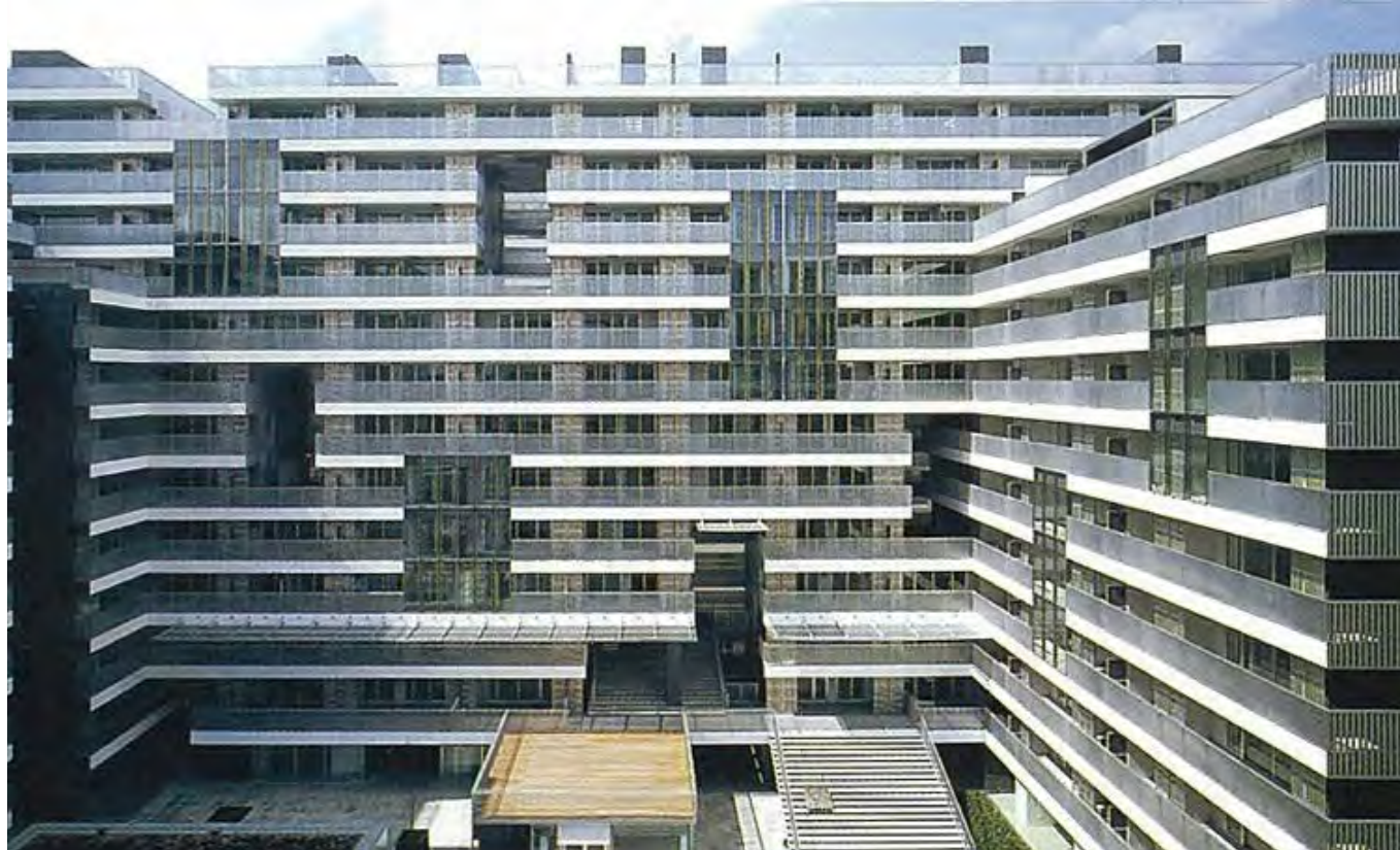
Vista de fachada
