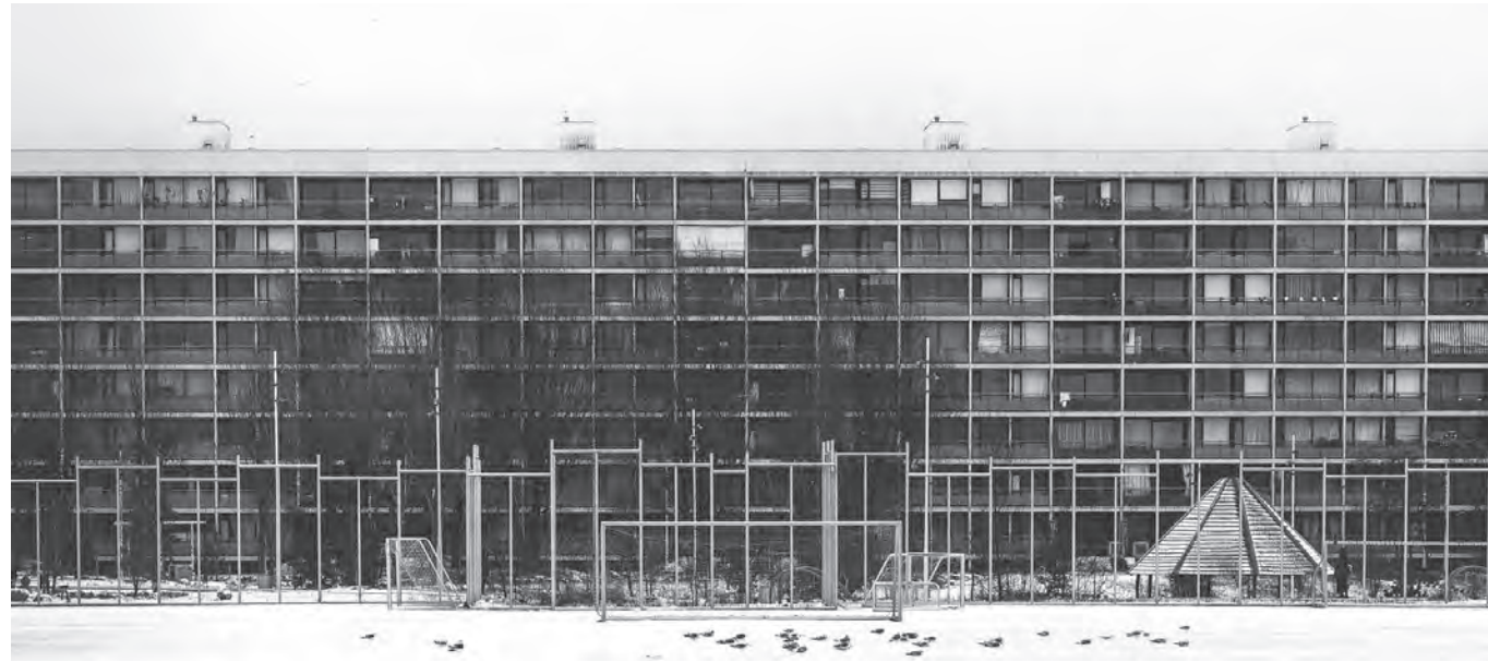
Vista de fachada
