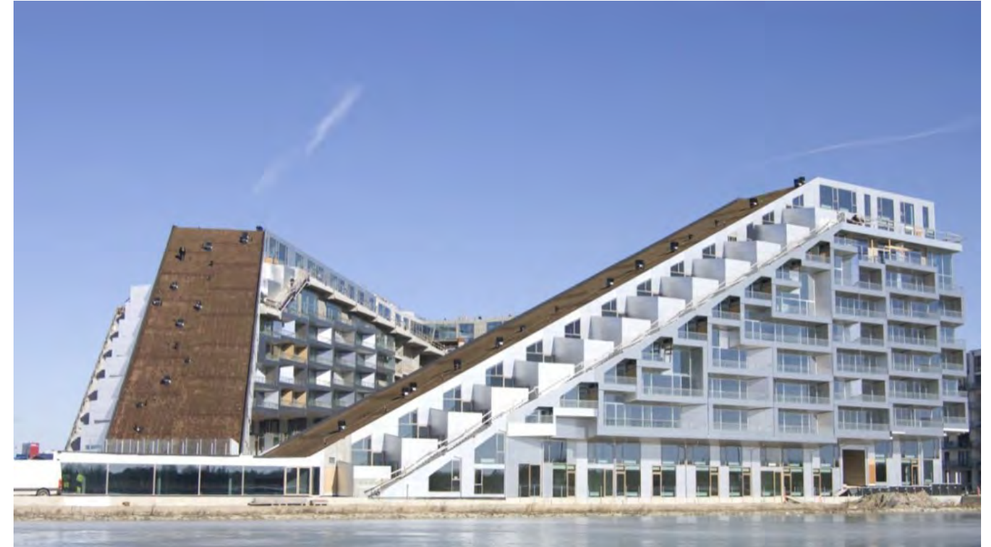
Vista de fachada
