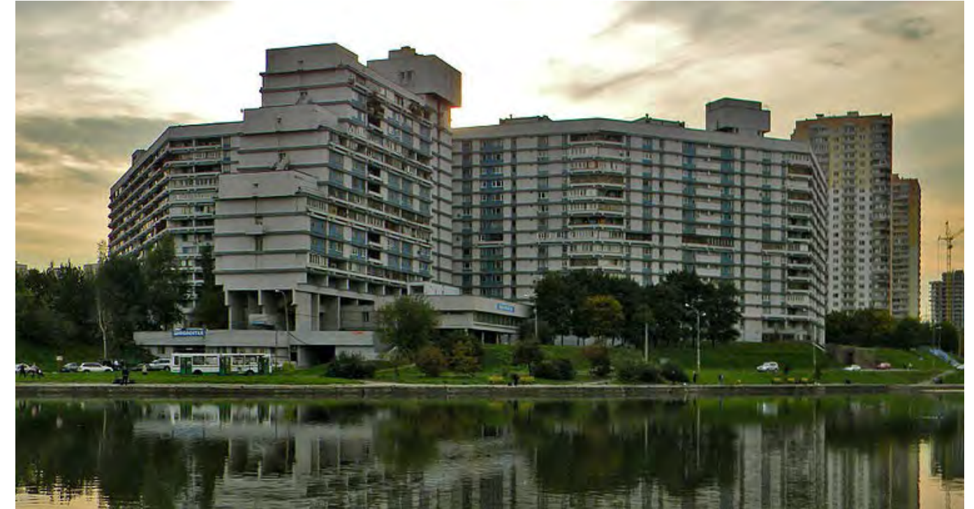
Vista de fachada
