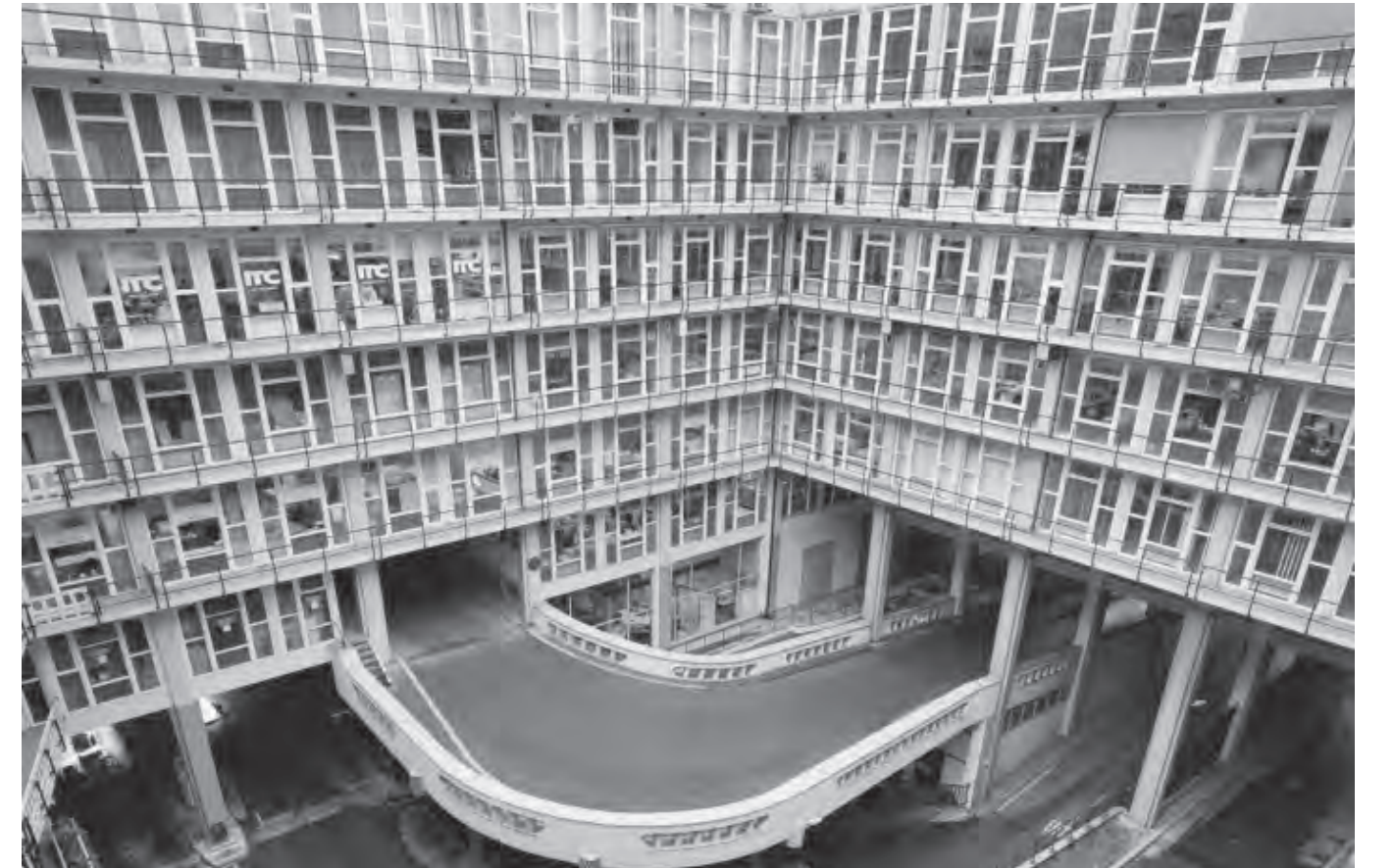
Vista de fachada
