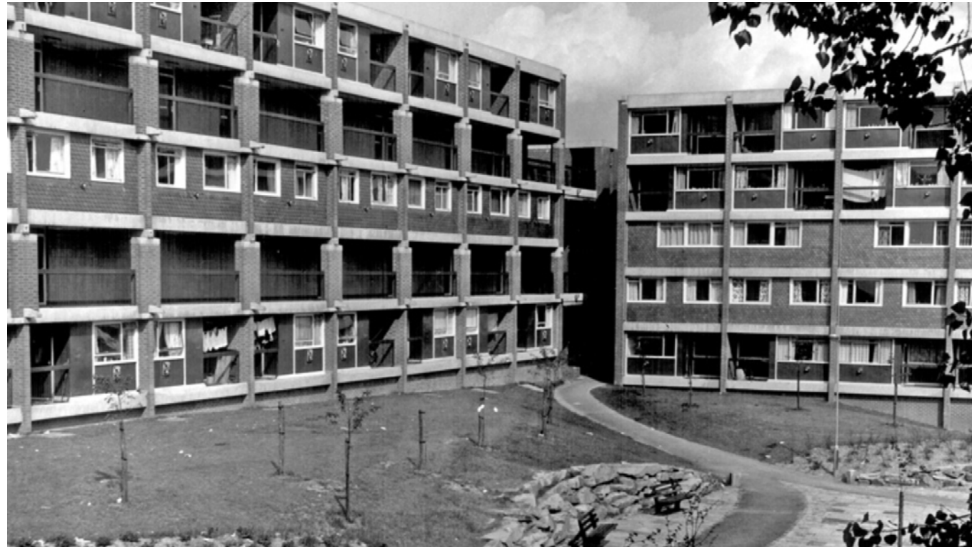
Vista de fachada
