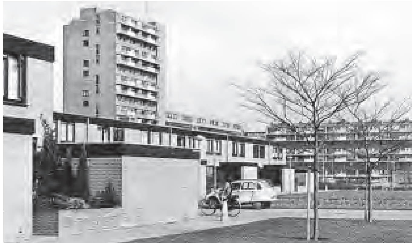
Vista de fachada
