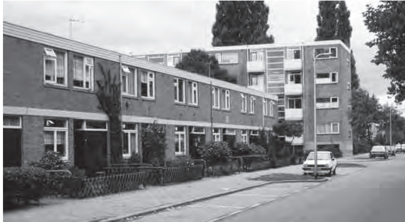
Vista de fachada
