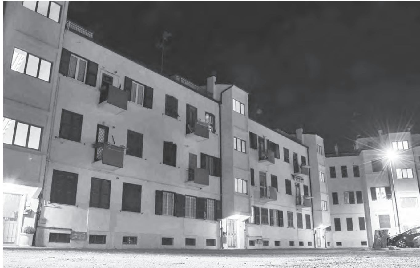
Vista de fachada
