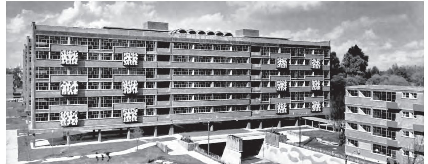
Vista de fachada
