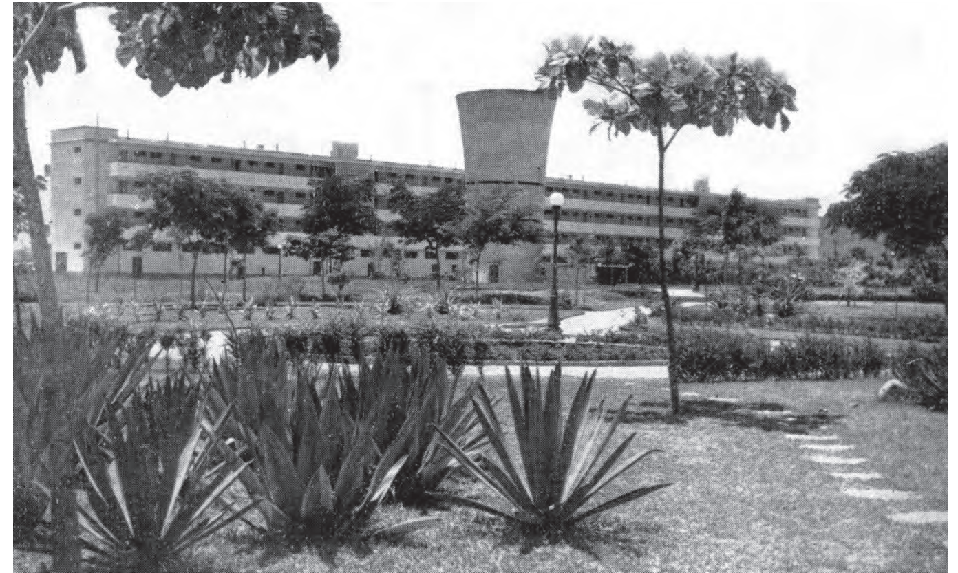
Vista de fachada
