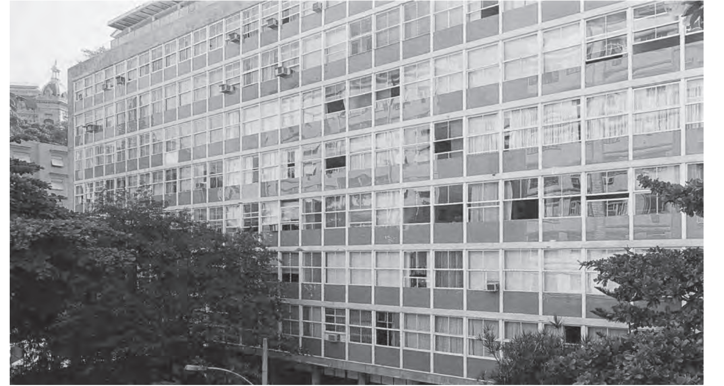
Vista de fachada
