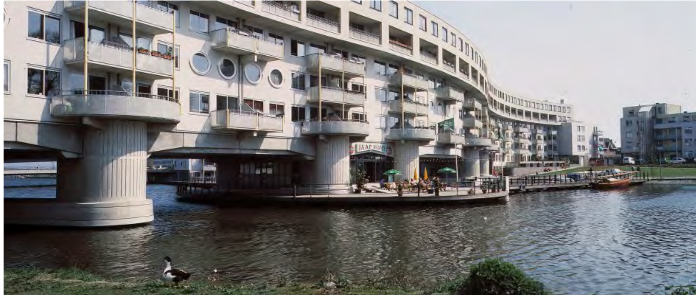
Vista de fachada
