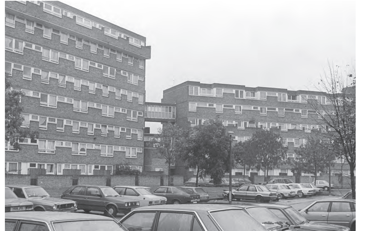
Vista de fachada
