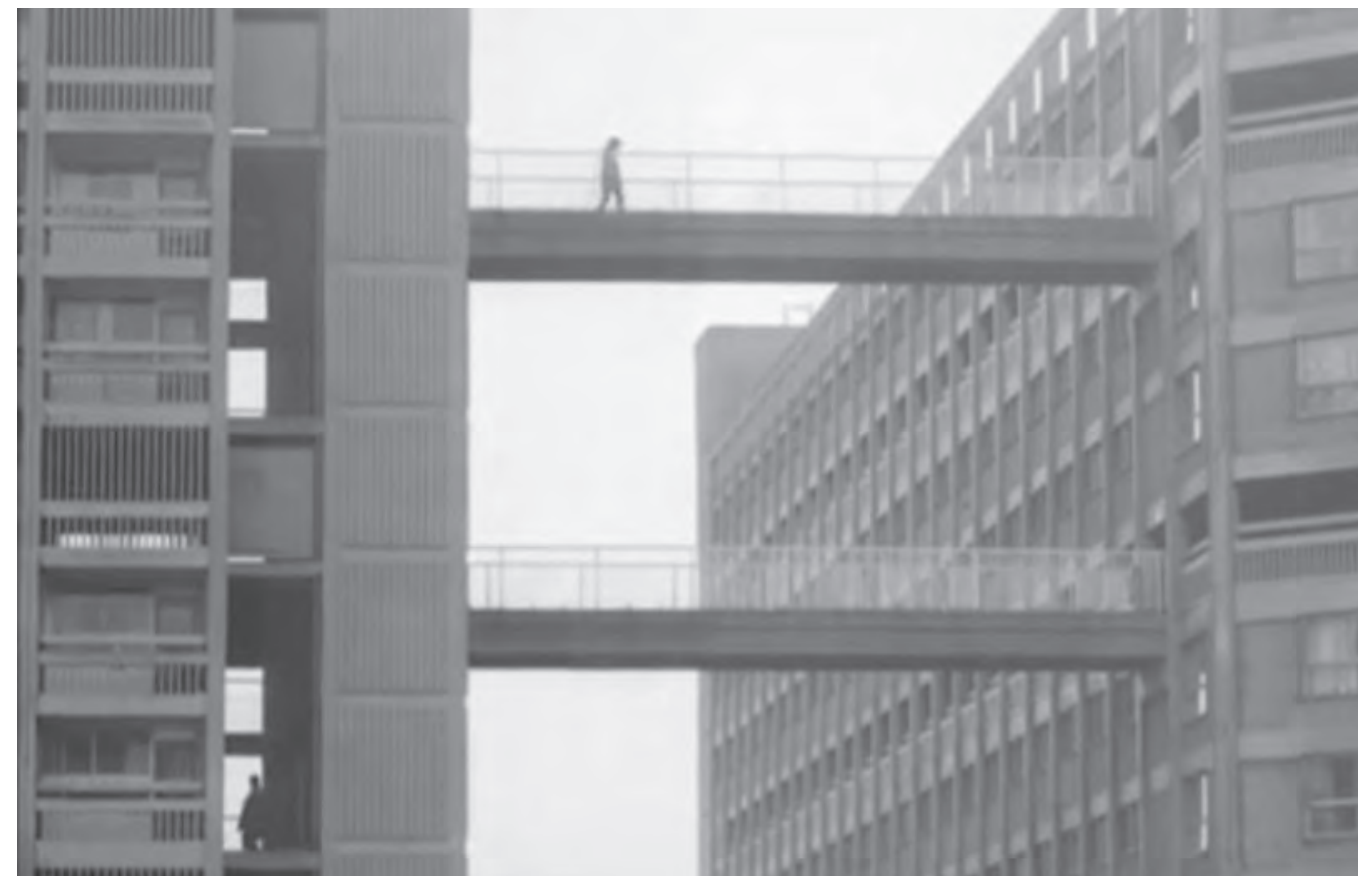
Vista de puentes de conexión entre calles elevadas
