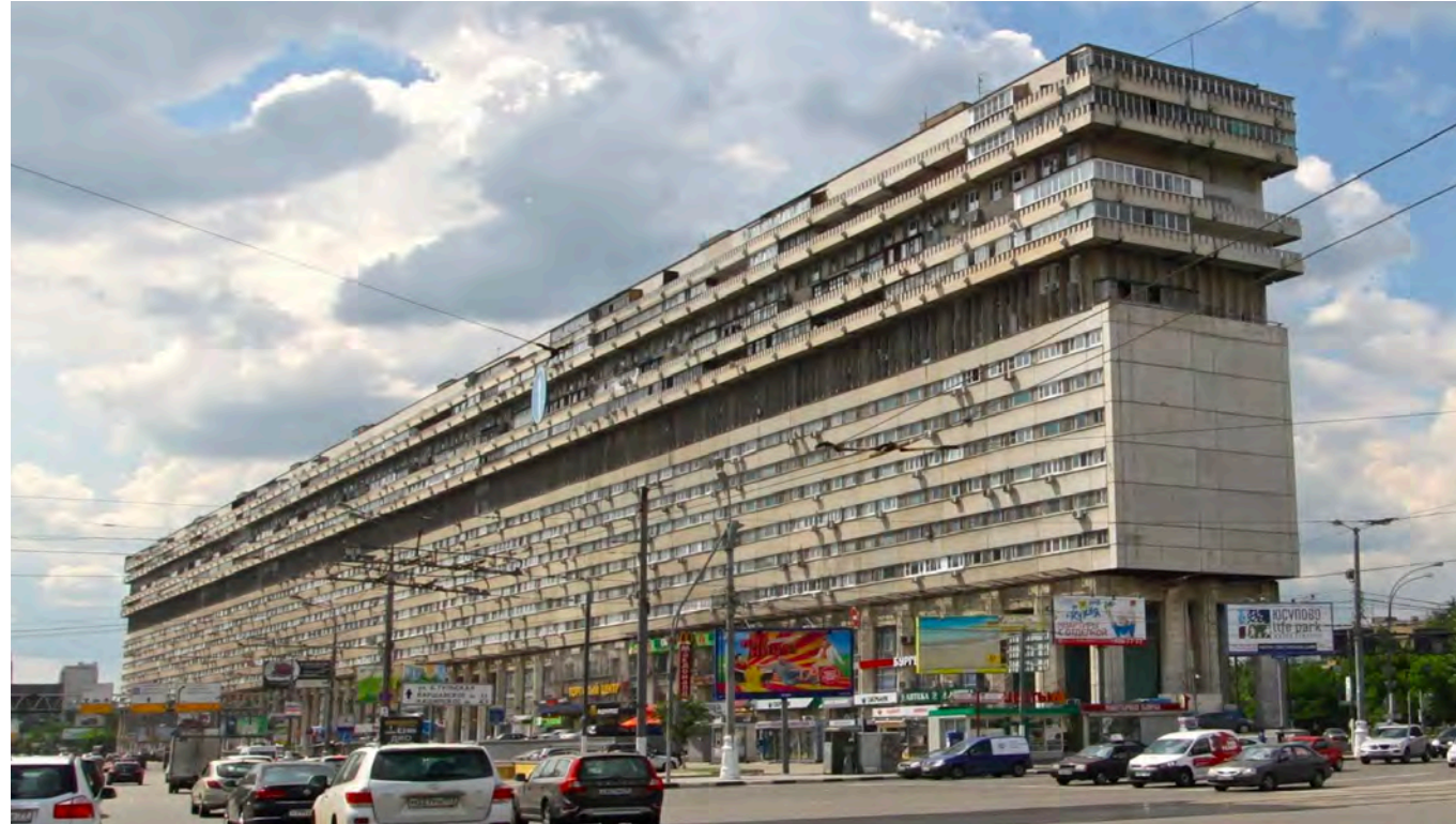
Vista de fachada
