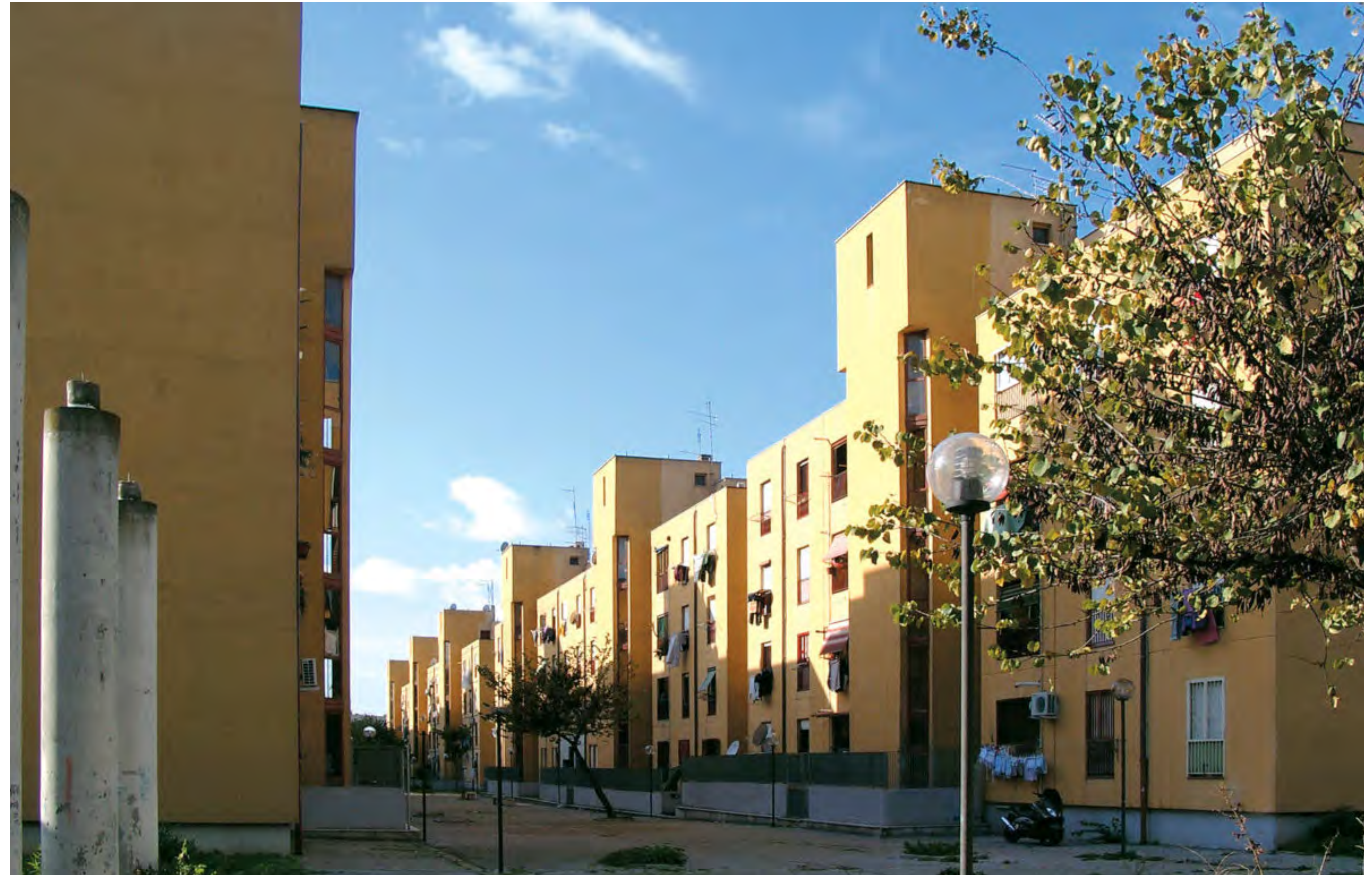
Vista de fachada
