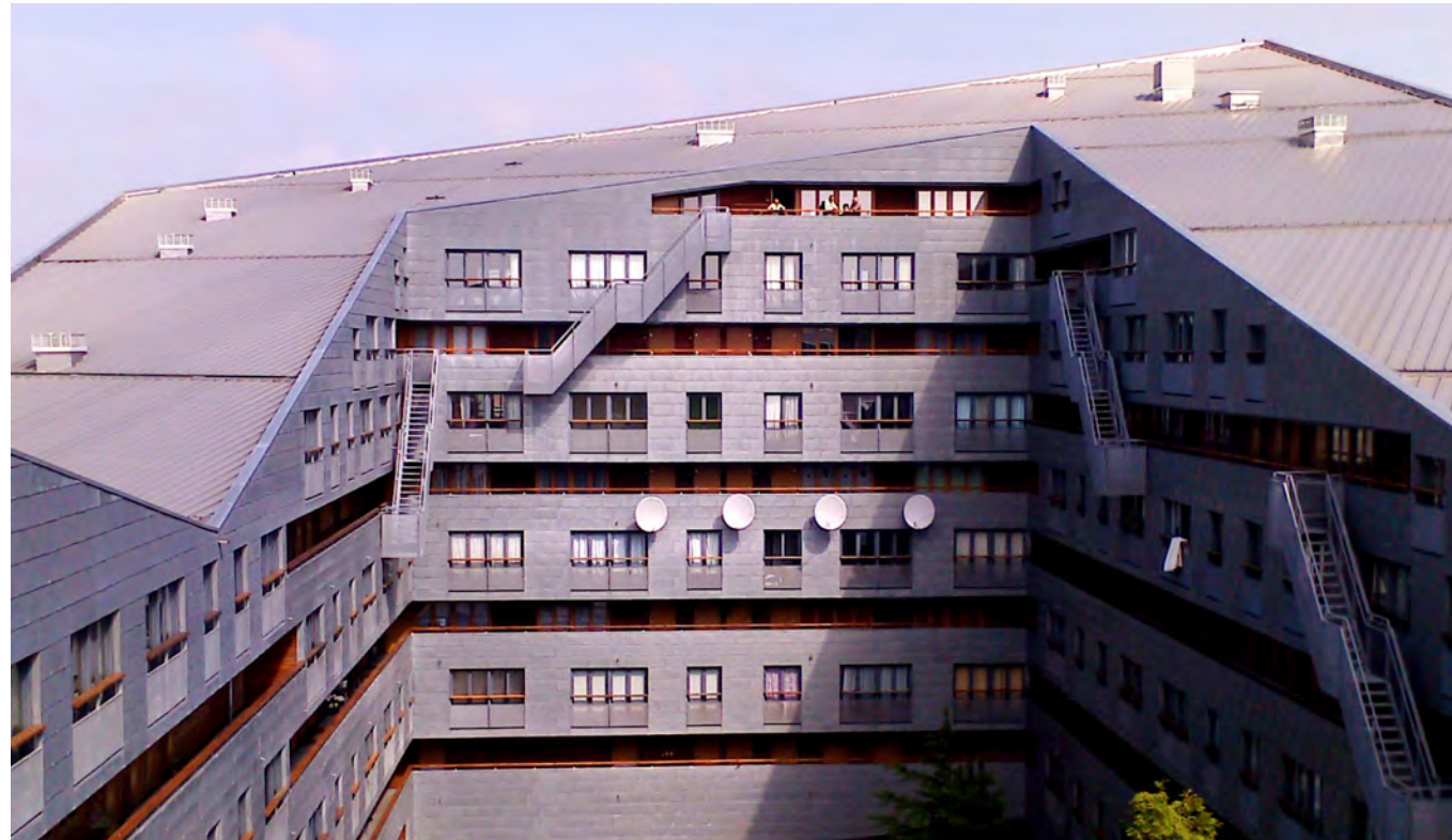
Vista de fachada interior
