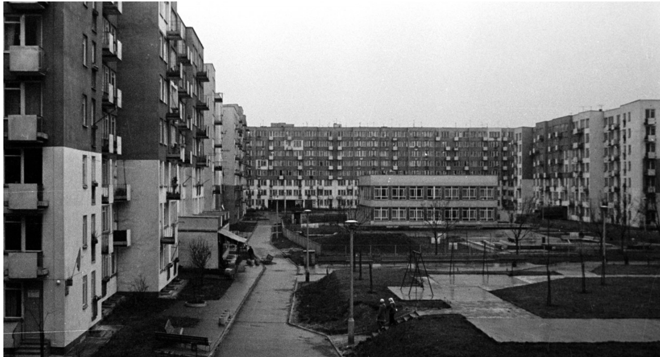
Vista de fachada y patio
