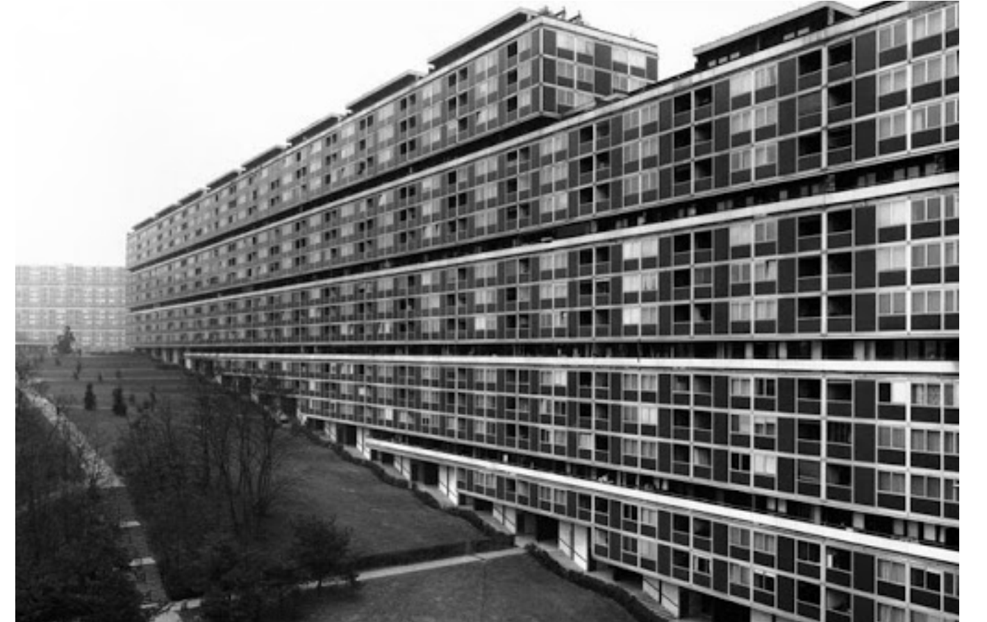
Vista de fachada
