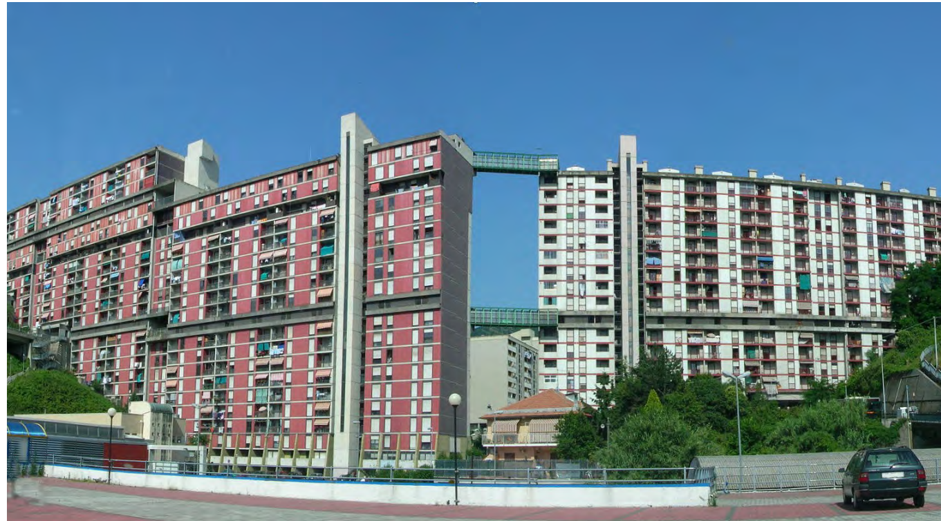
Vista de fachada
