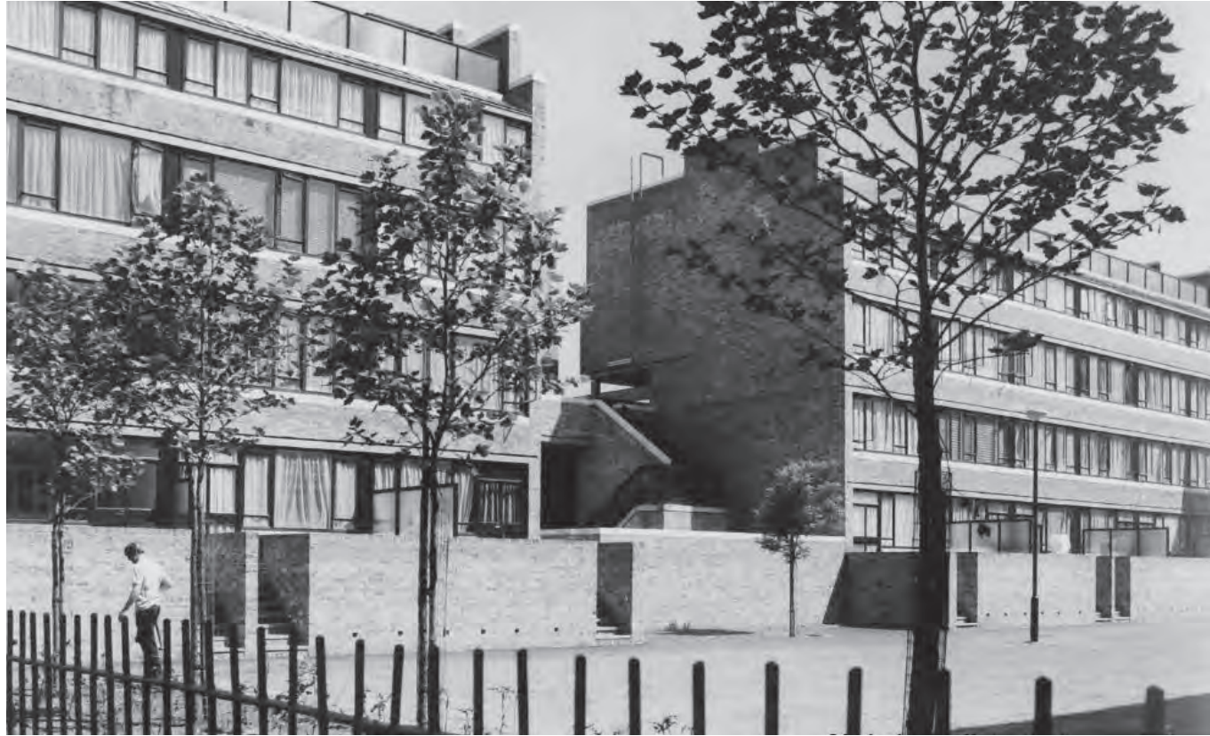
Vista de fachada
