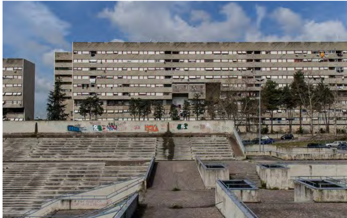
Vista de fachada
