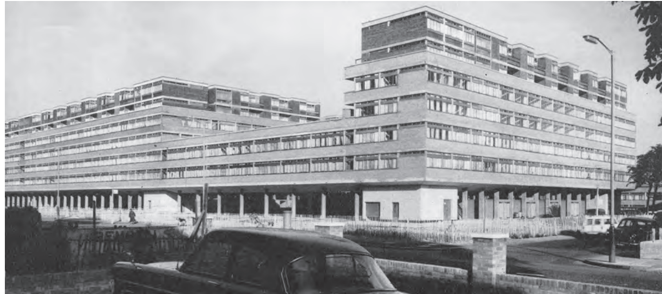
Vista de fachada
