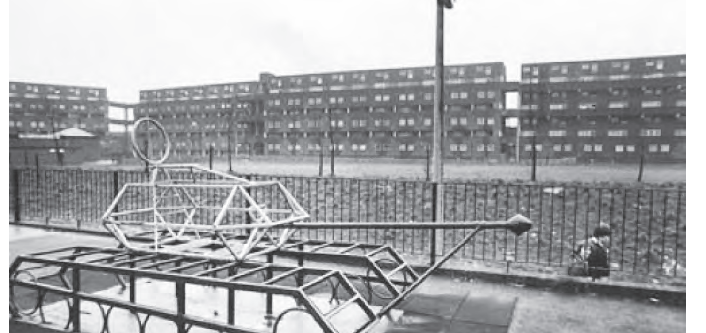
Vista de fachada
