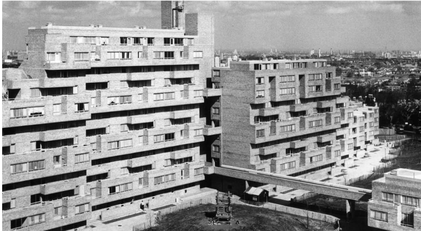
Vista de fachada
