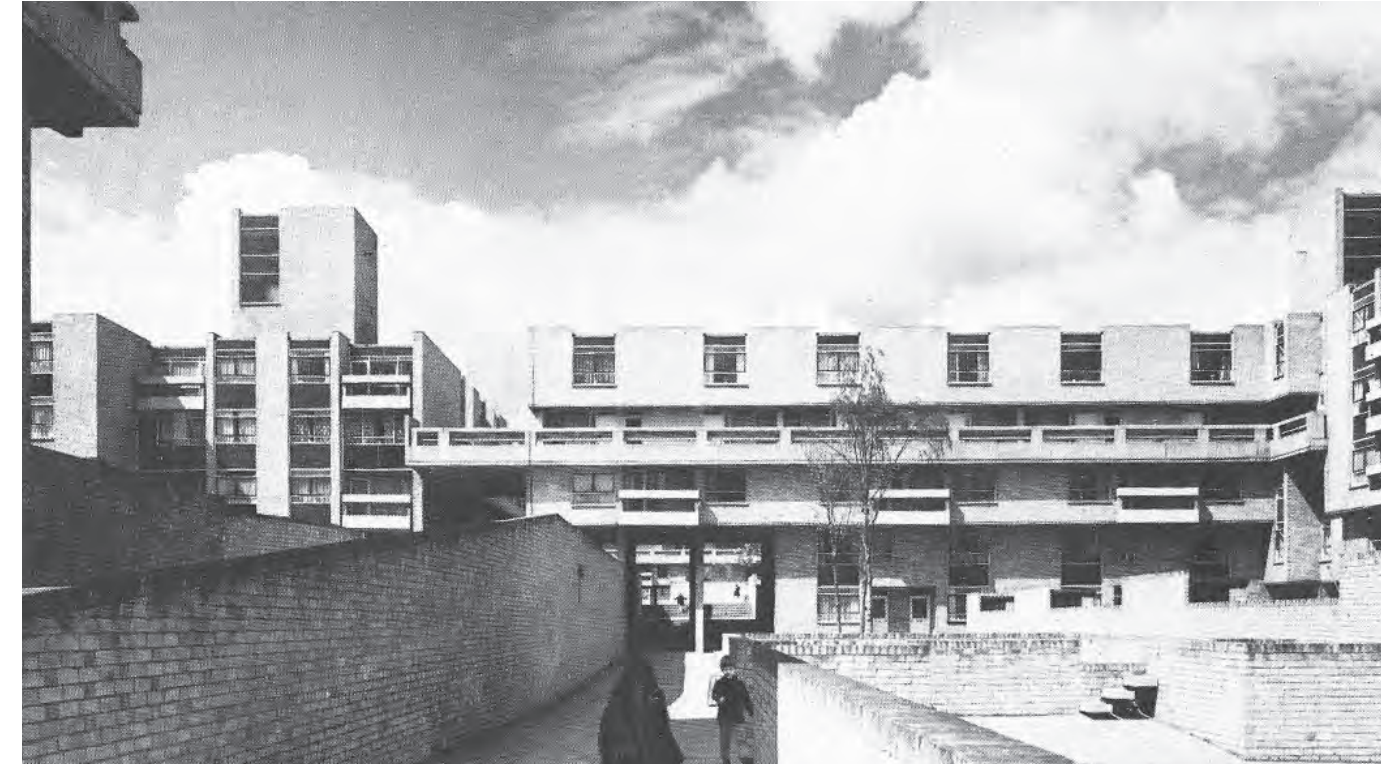
Vista de fachada
