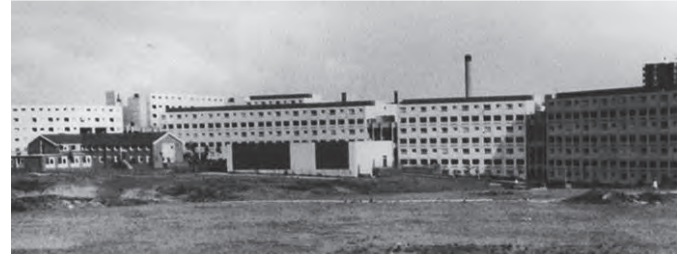
Vista de fachada
