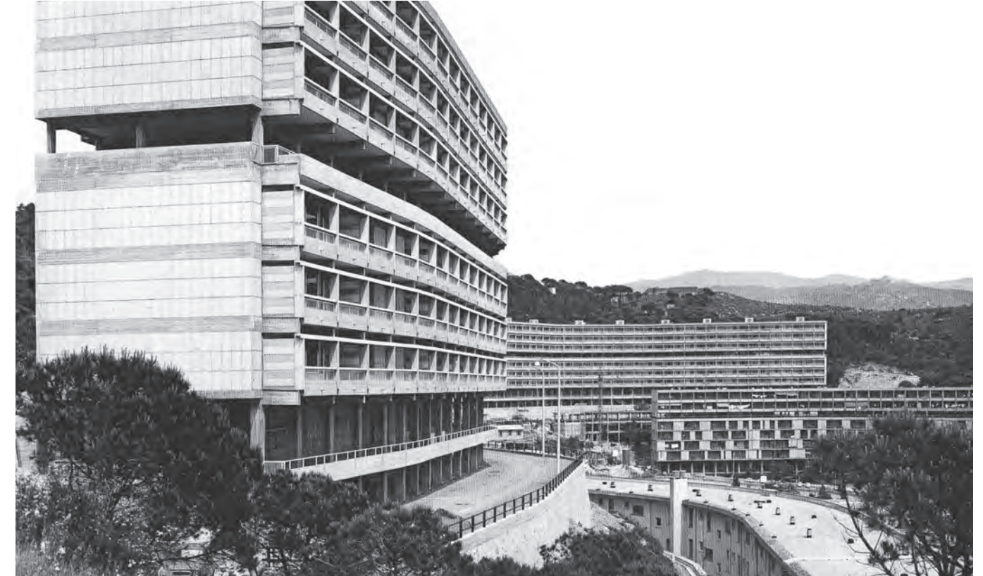
Vista de fachada de bloque A
