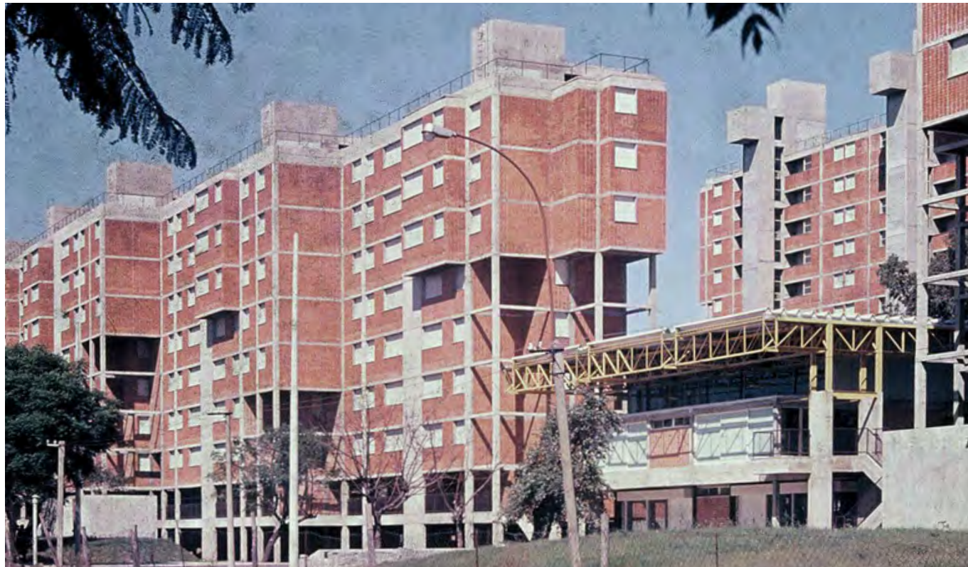
Vista de fachada
