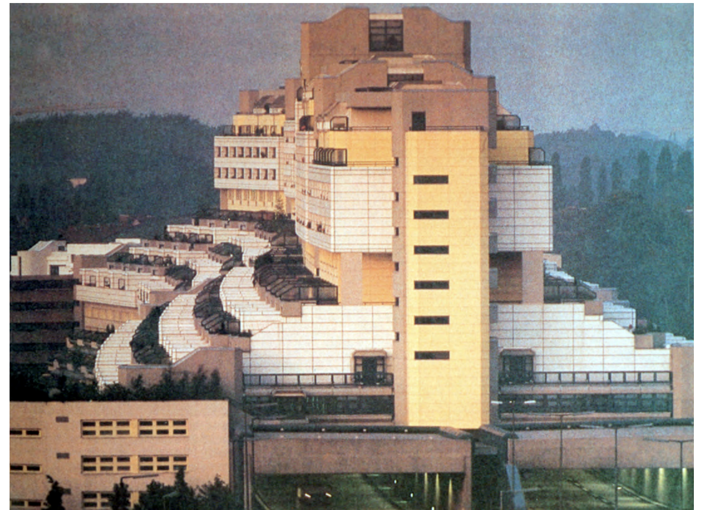
Vista de fachada
