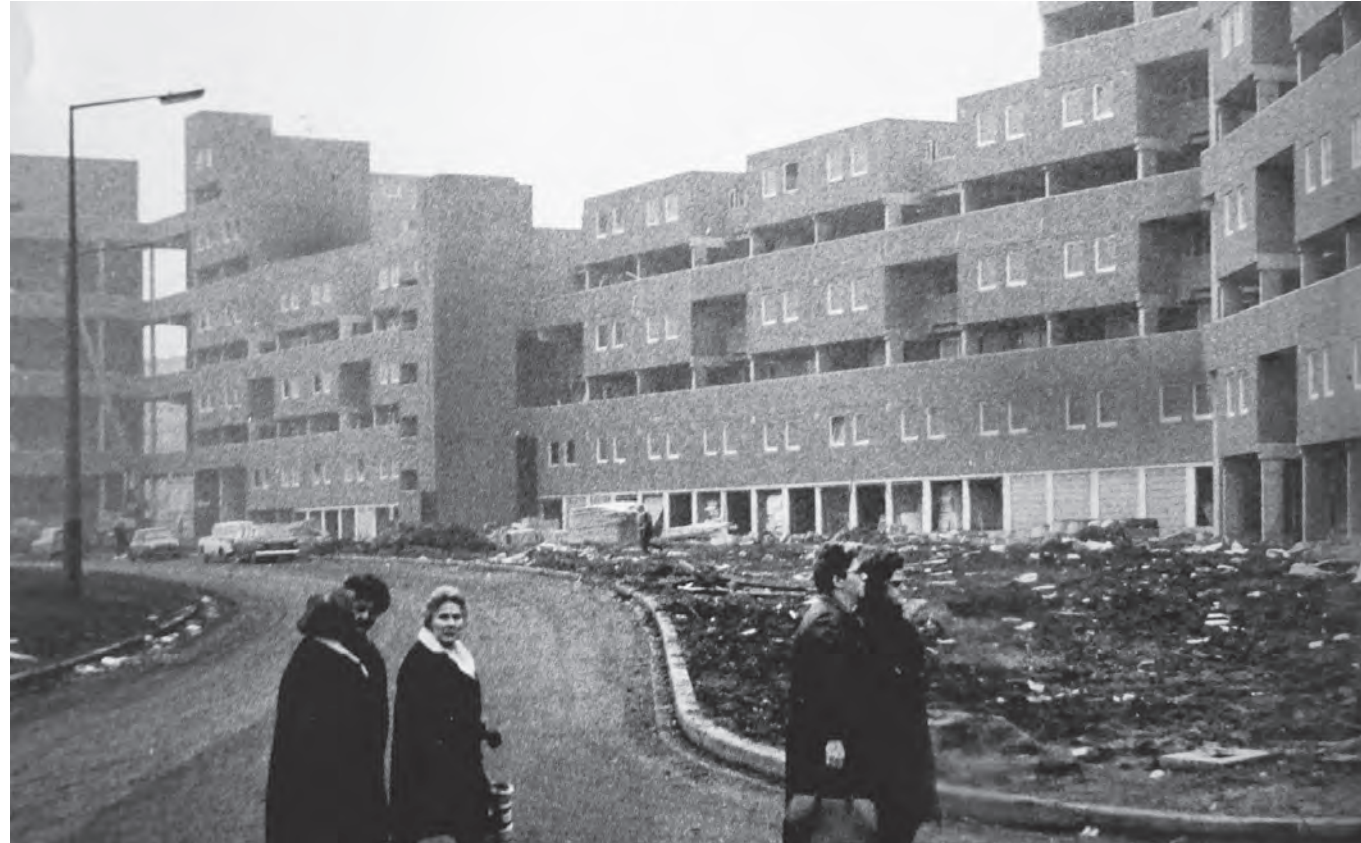
Vista de fachada
