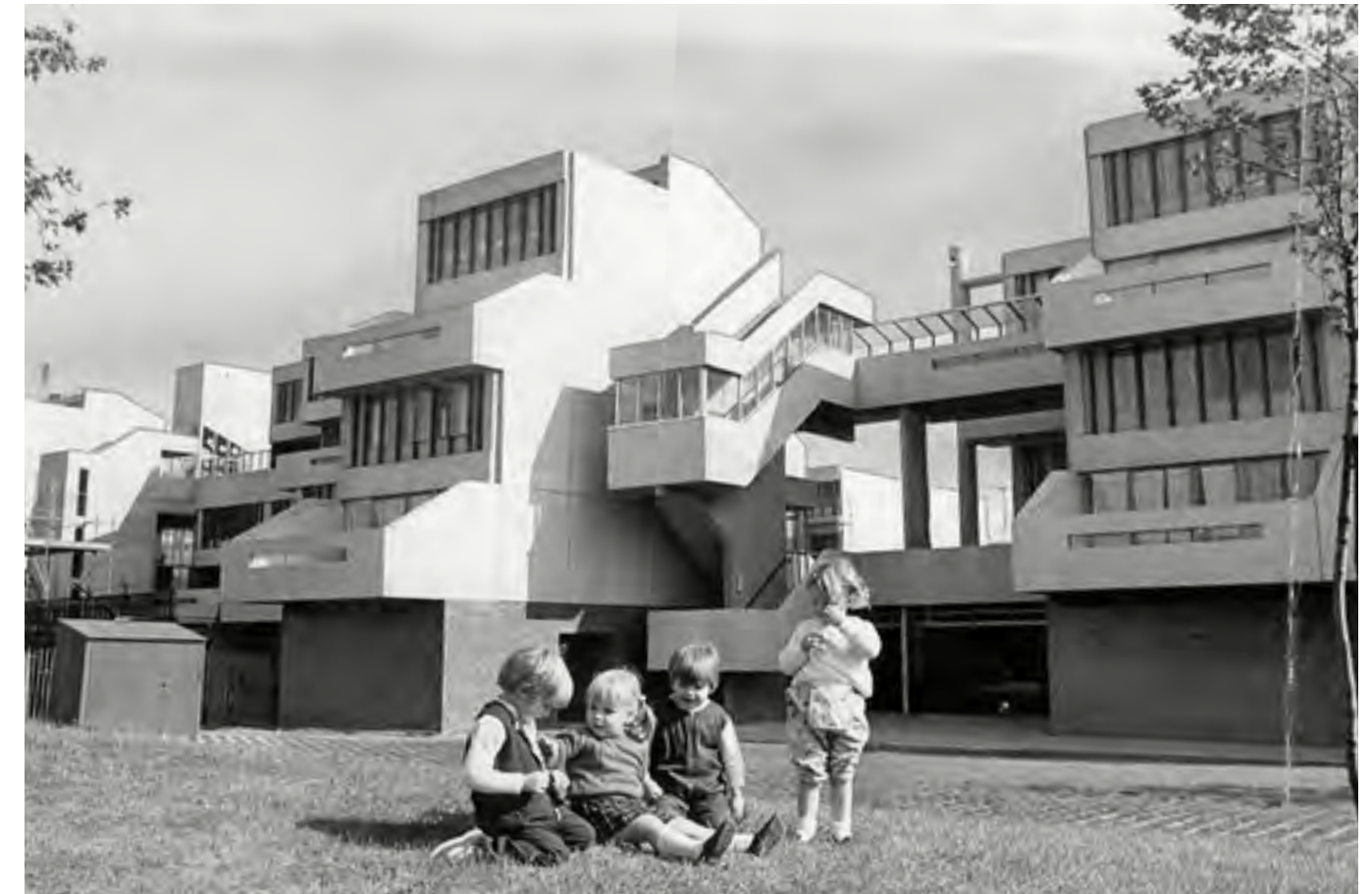
Vista de fachada
