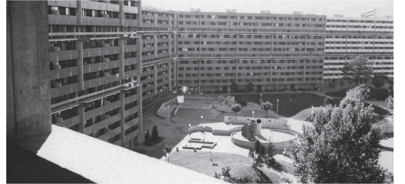
Vista de fachada
