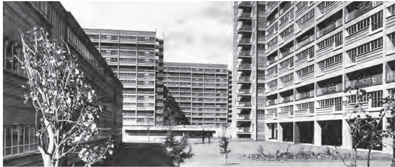
Vista de patio interior
