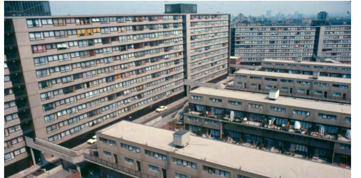
Vista de fachada
