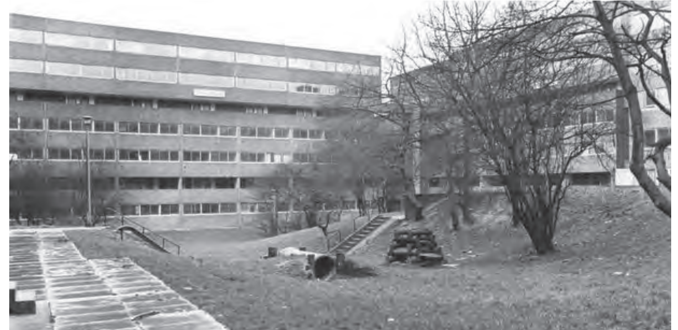
Vista de fachada
