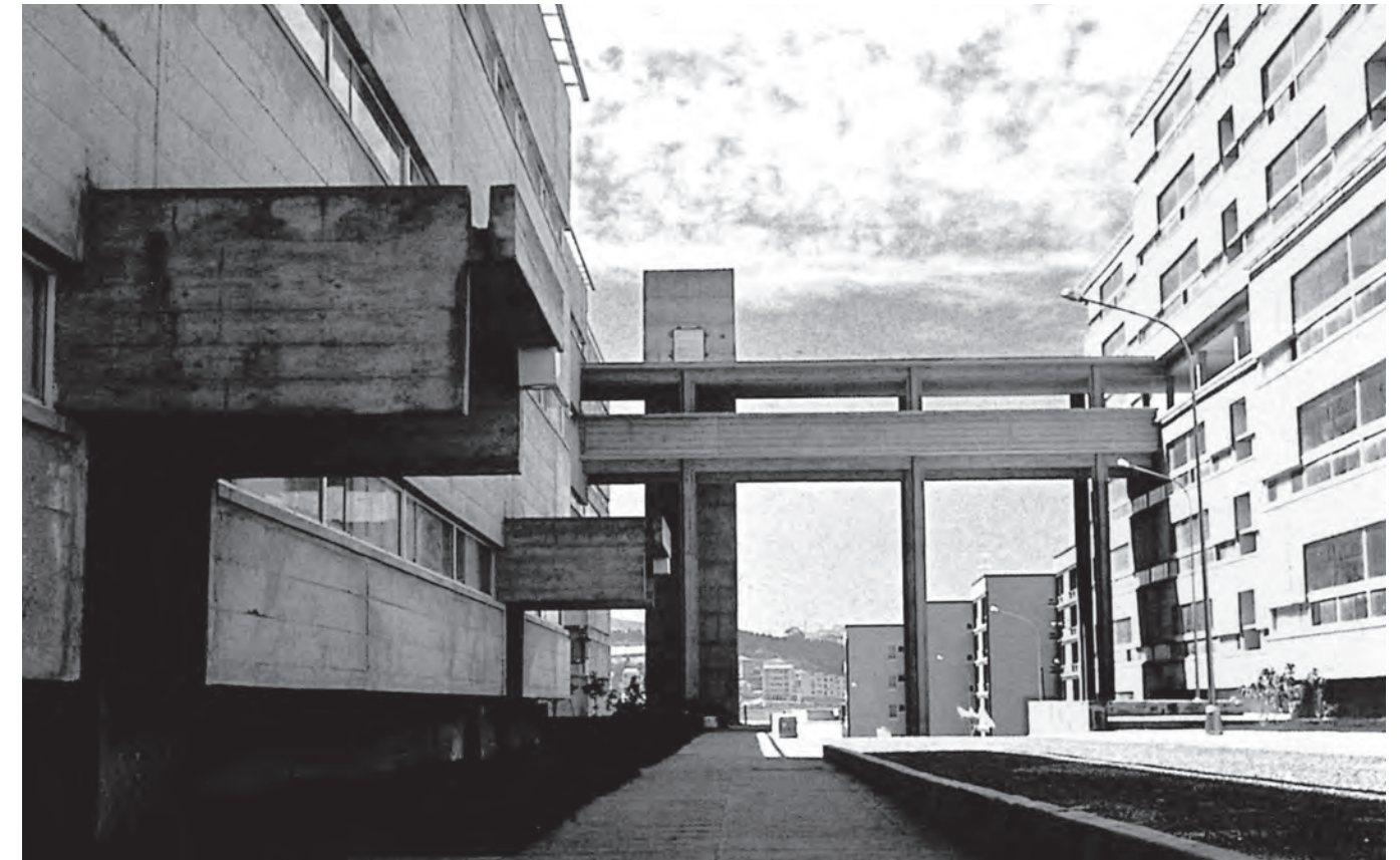
Vista de puente de conexión y fachada
