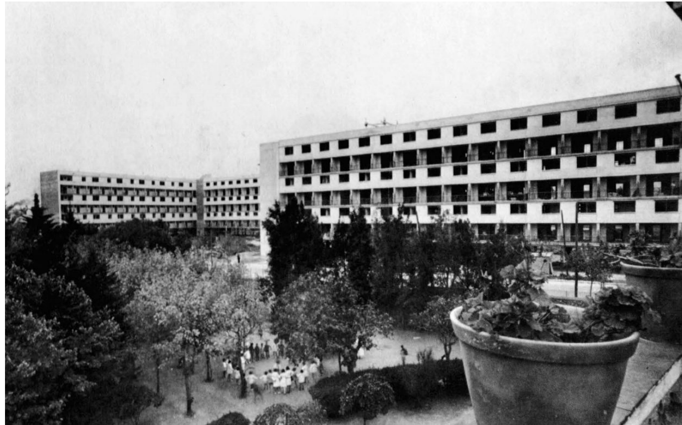
Vista de patio central desde calle elevada
