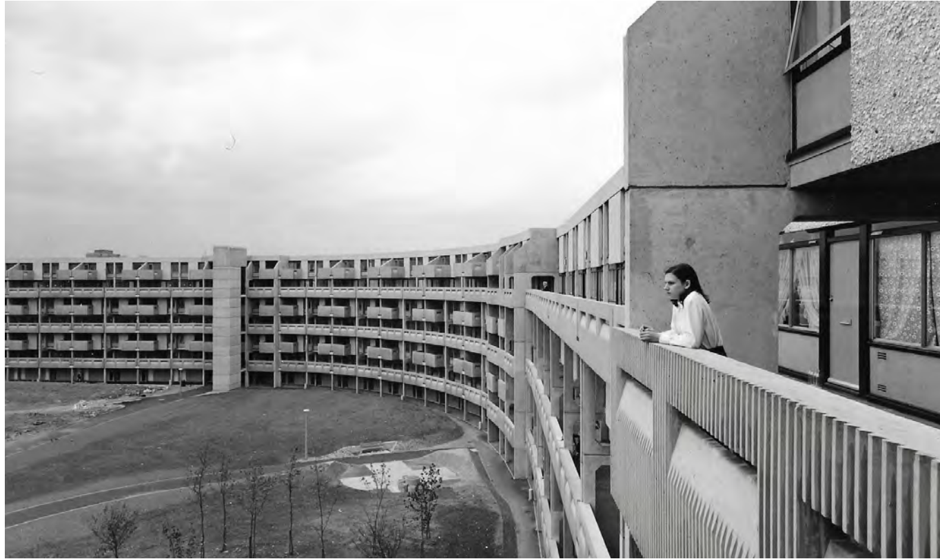
Vista de fachada
