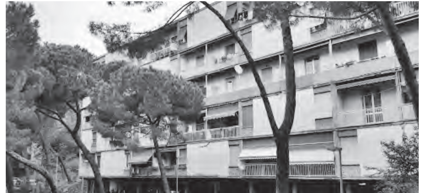
Vista de fachada
