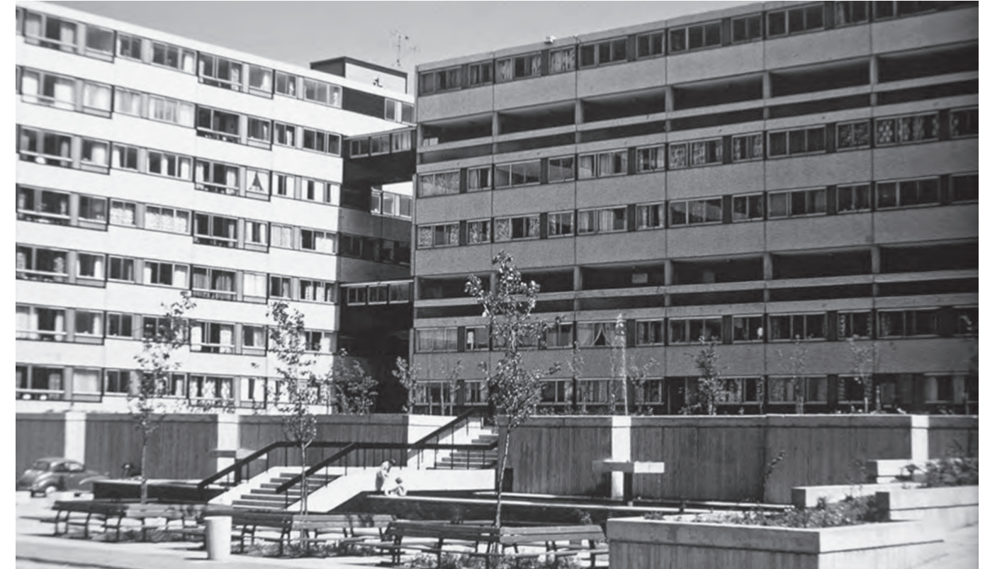
Vista de fachada
