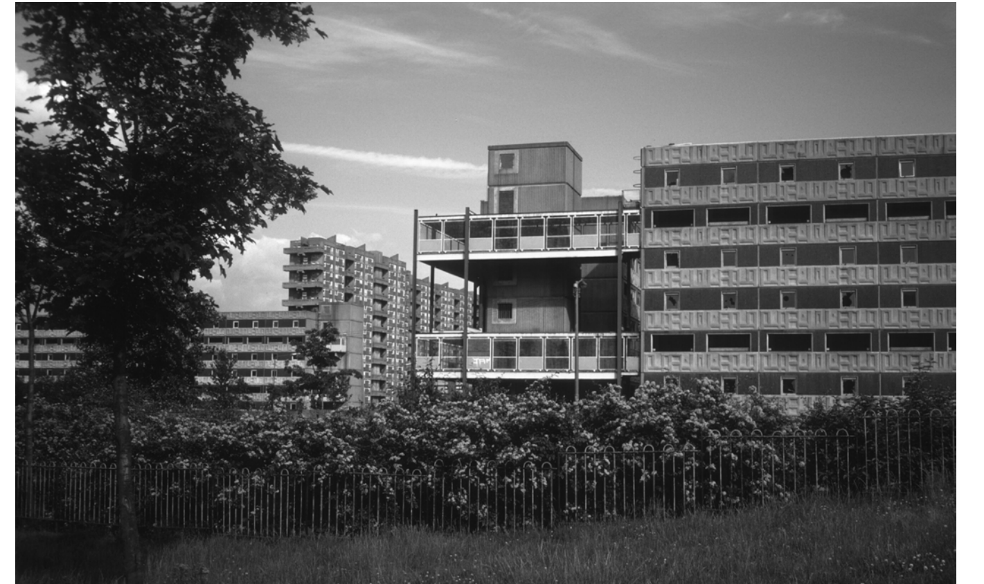
Vista de fachada
