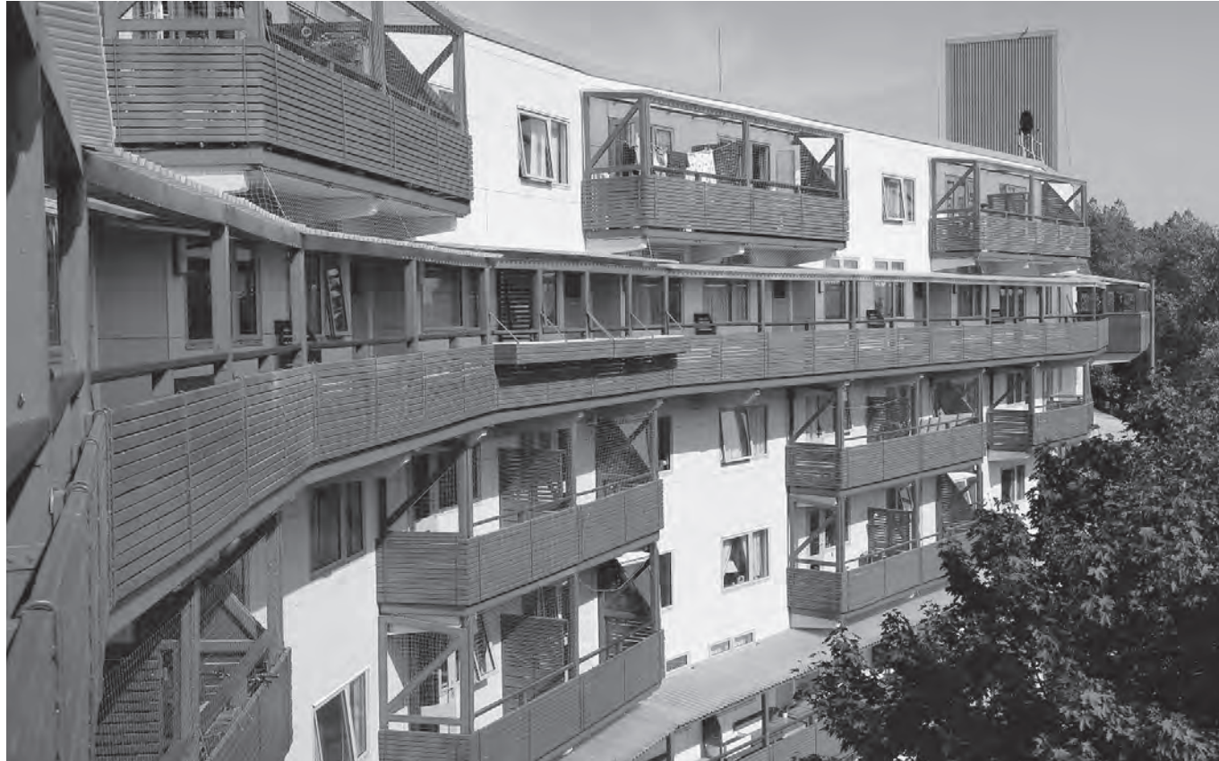
Vista de fachada
