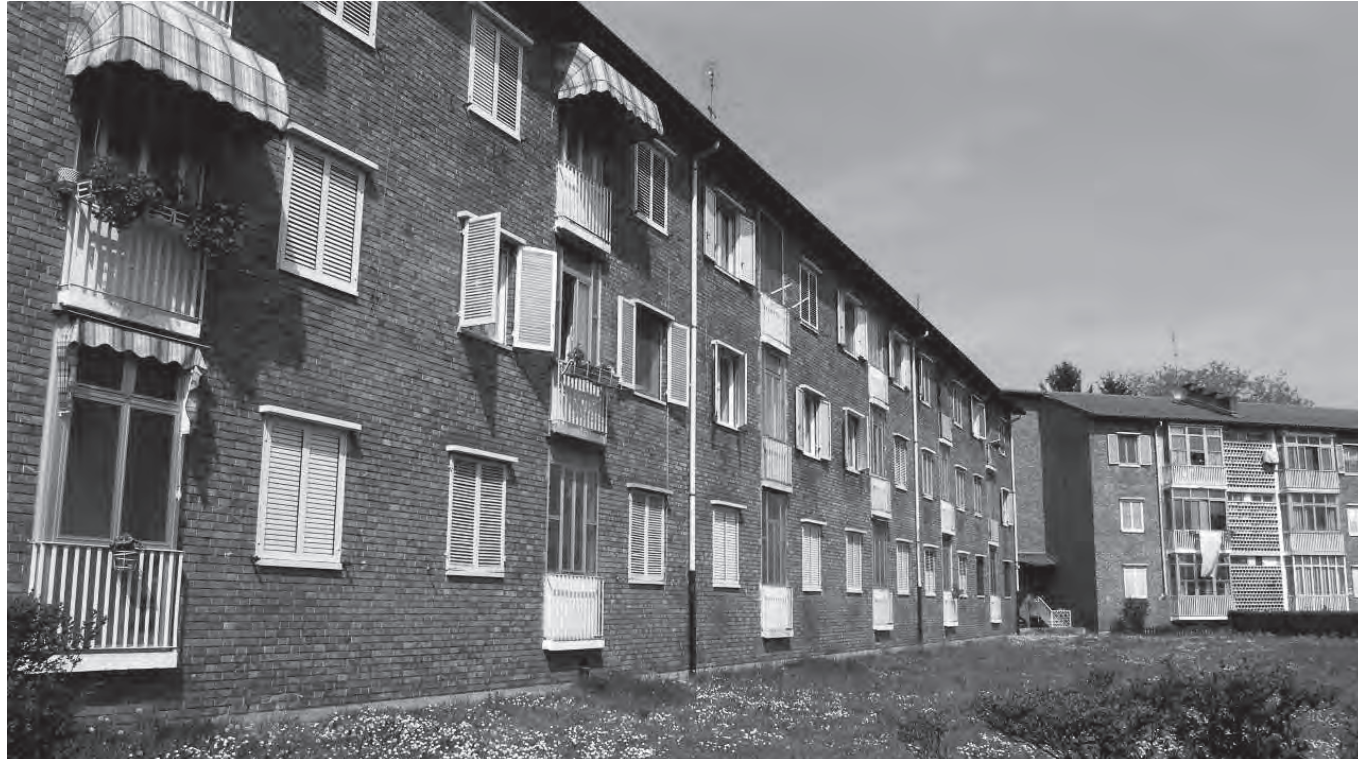
Vista de fachada
