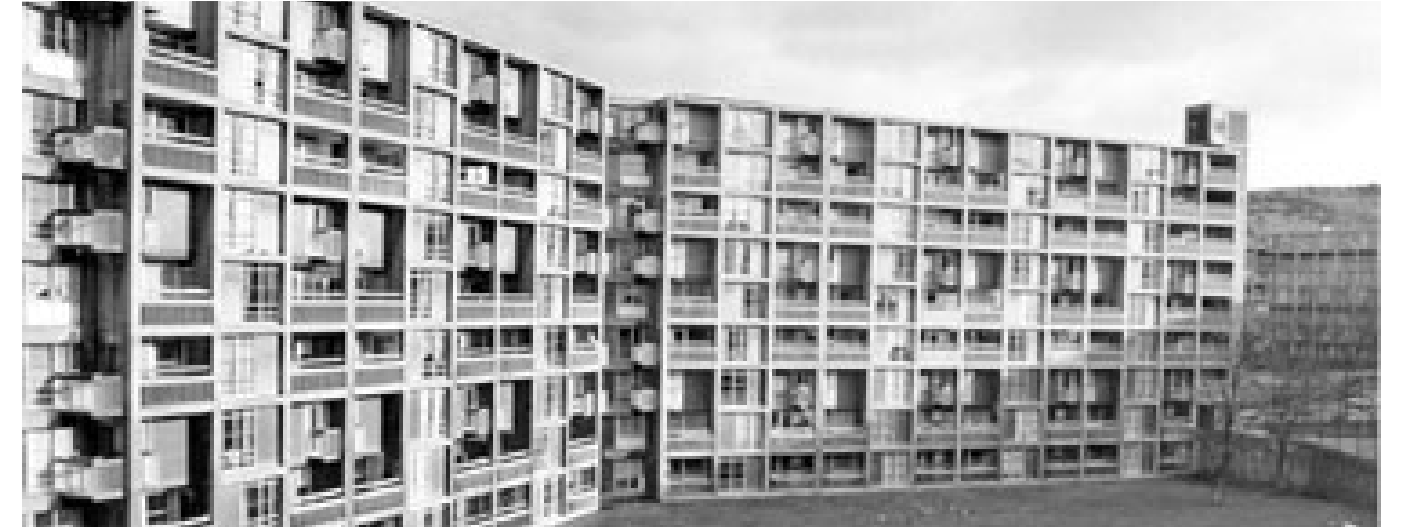
Vista de fachada
