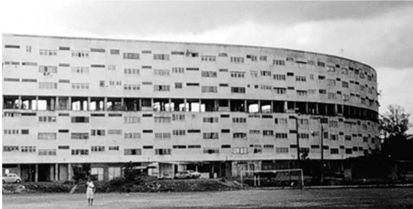
Vista de fachada
