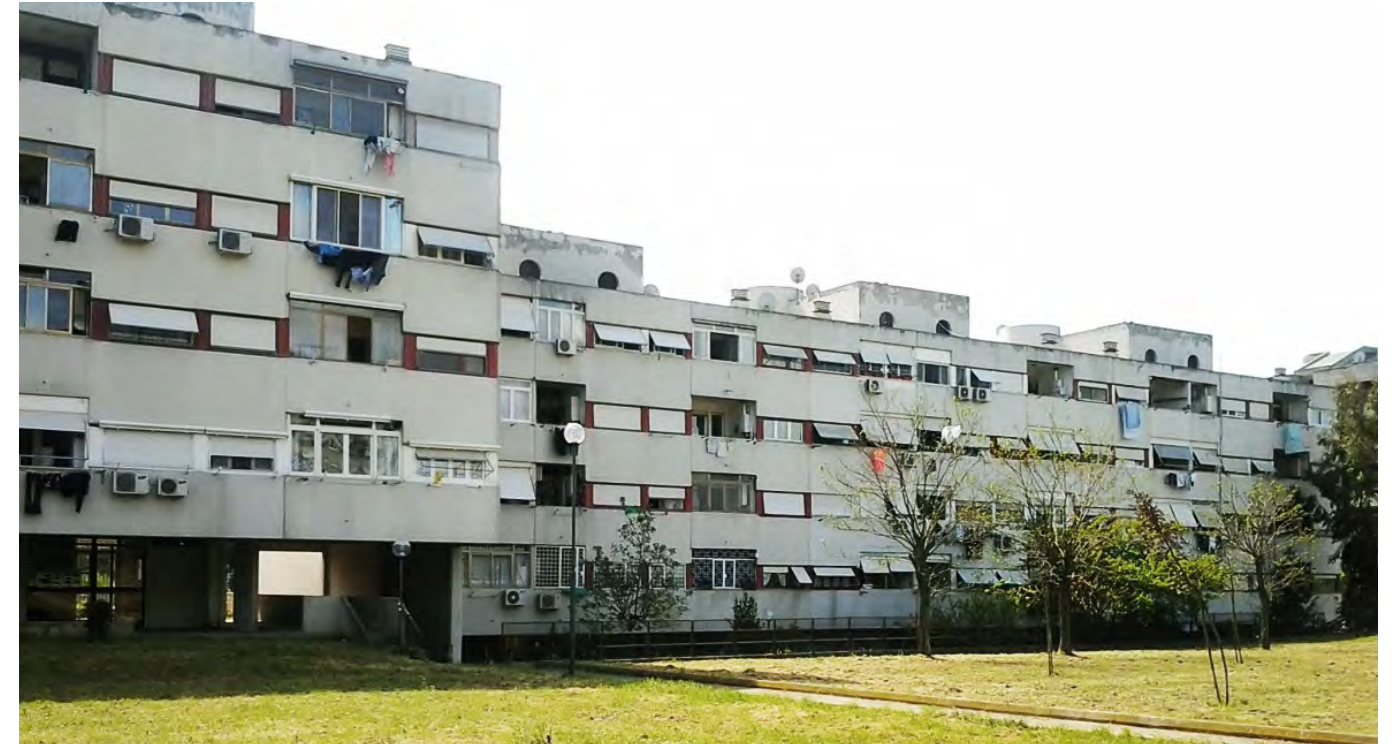
Vista de fachada
