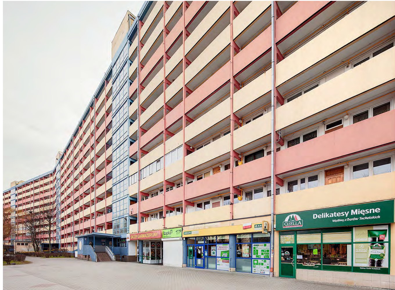
Vista de fachada
