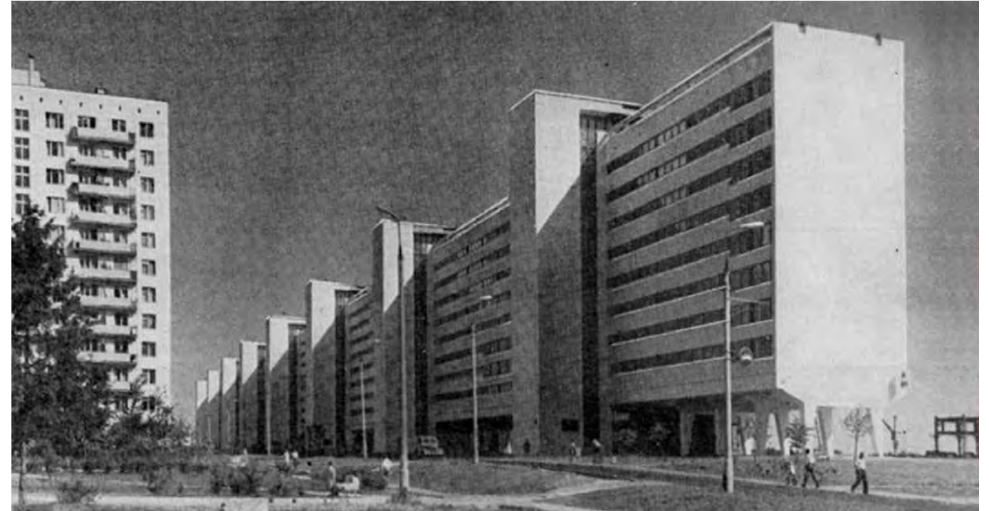
Vista de fachada
