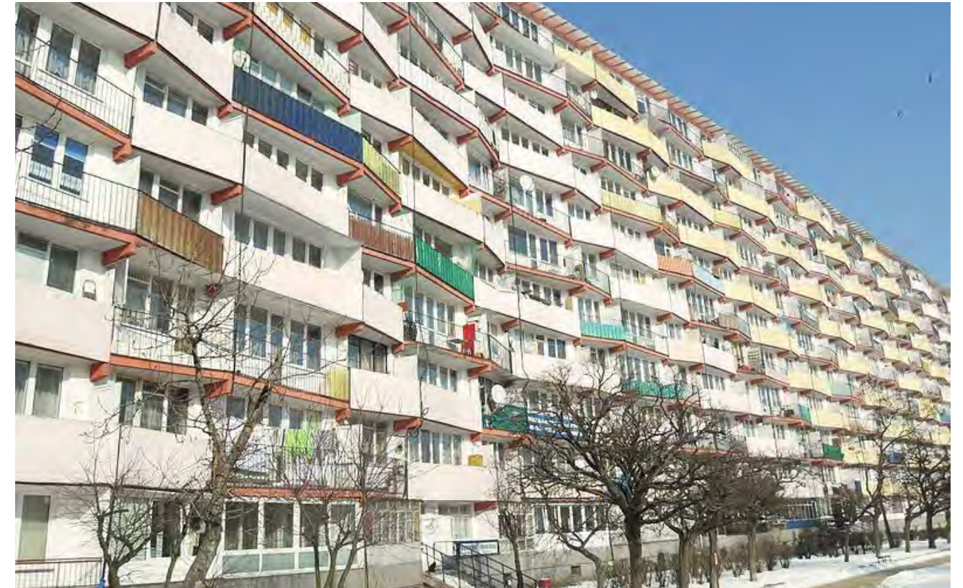
Vista de fachada
