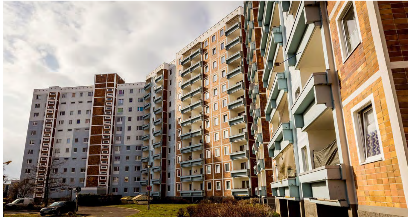
Vista de fachada
