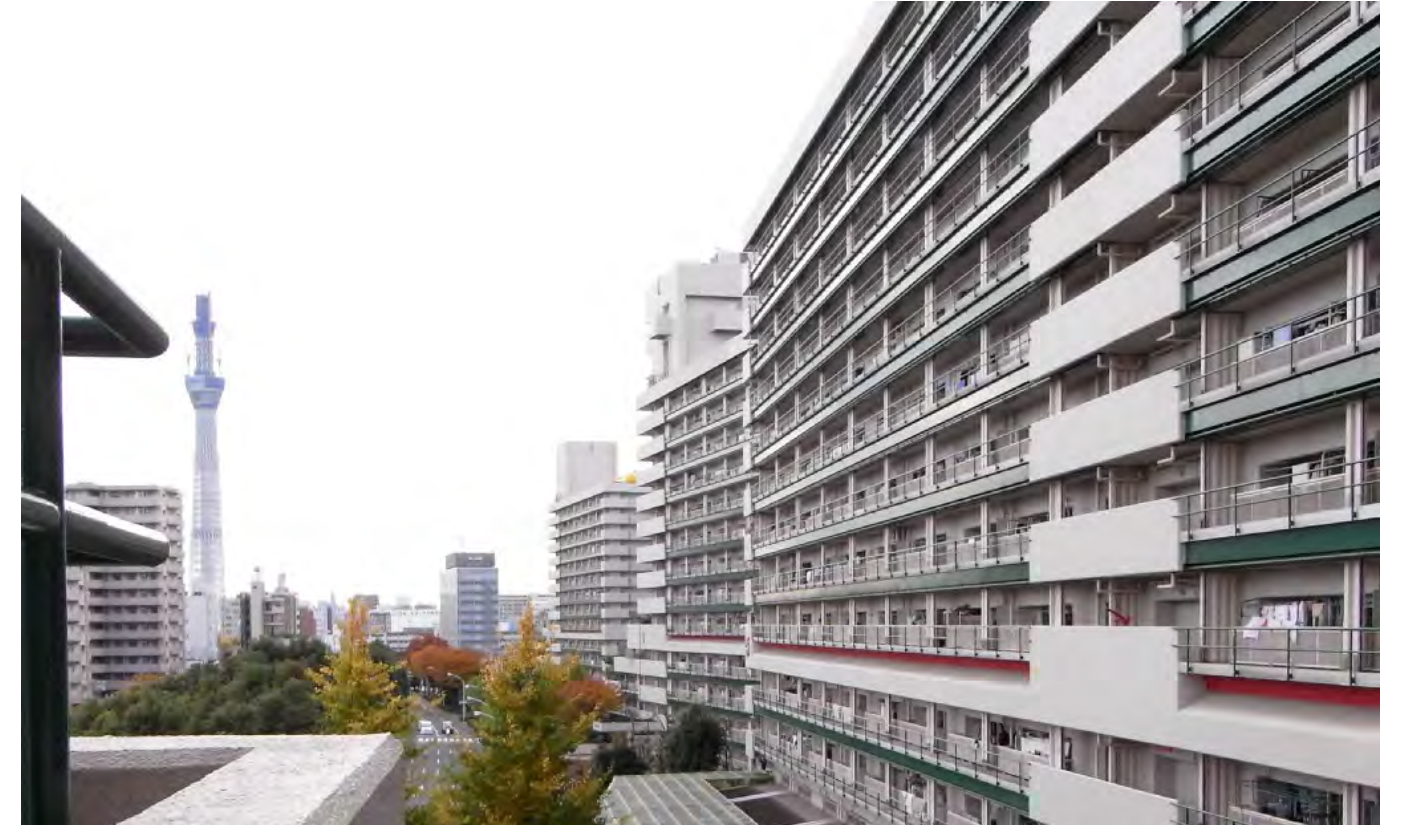
Vista de fachada
