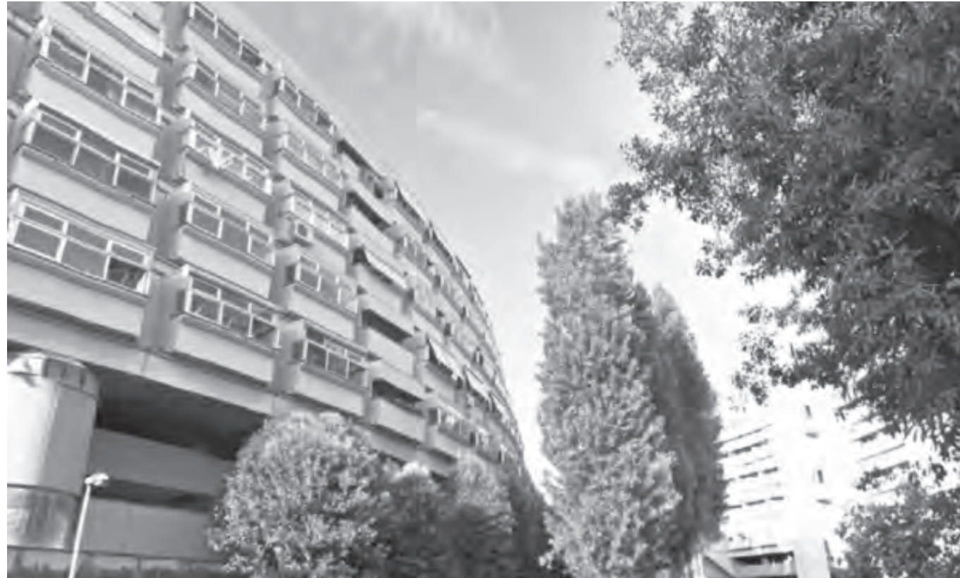
Vista de fachada
