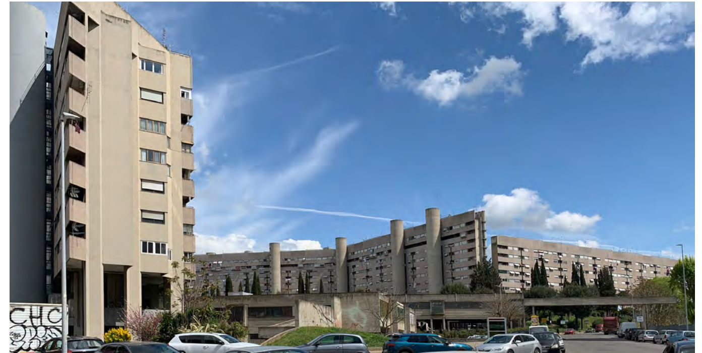
Vista de fachada
