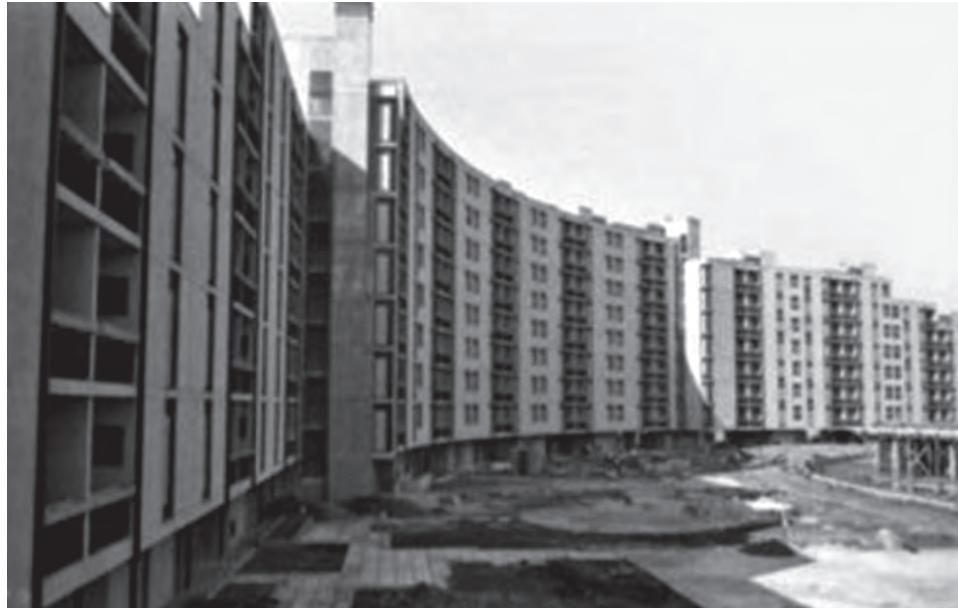
Vista de fachada
