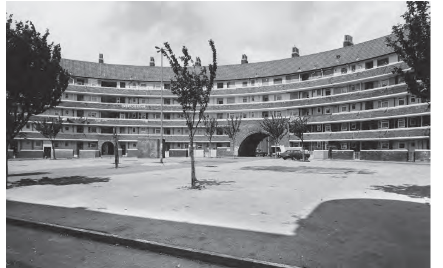
Vista de fachada interior
