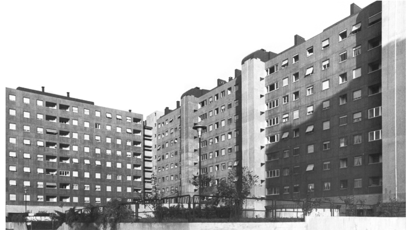
Vista de fachada
