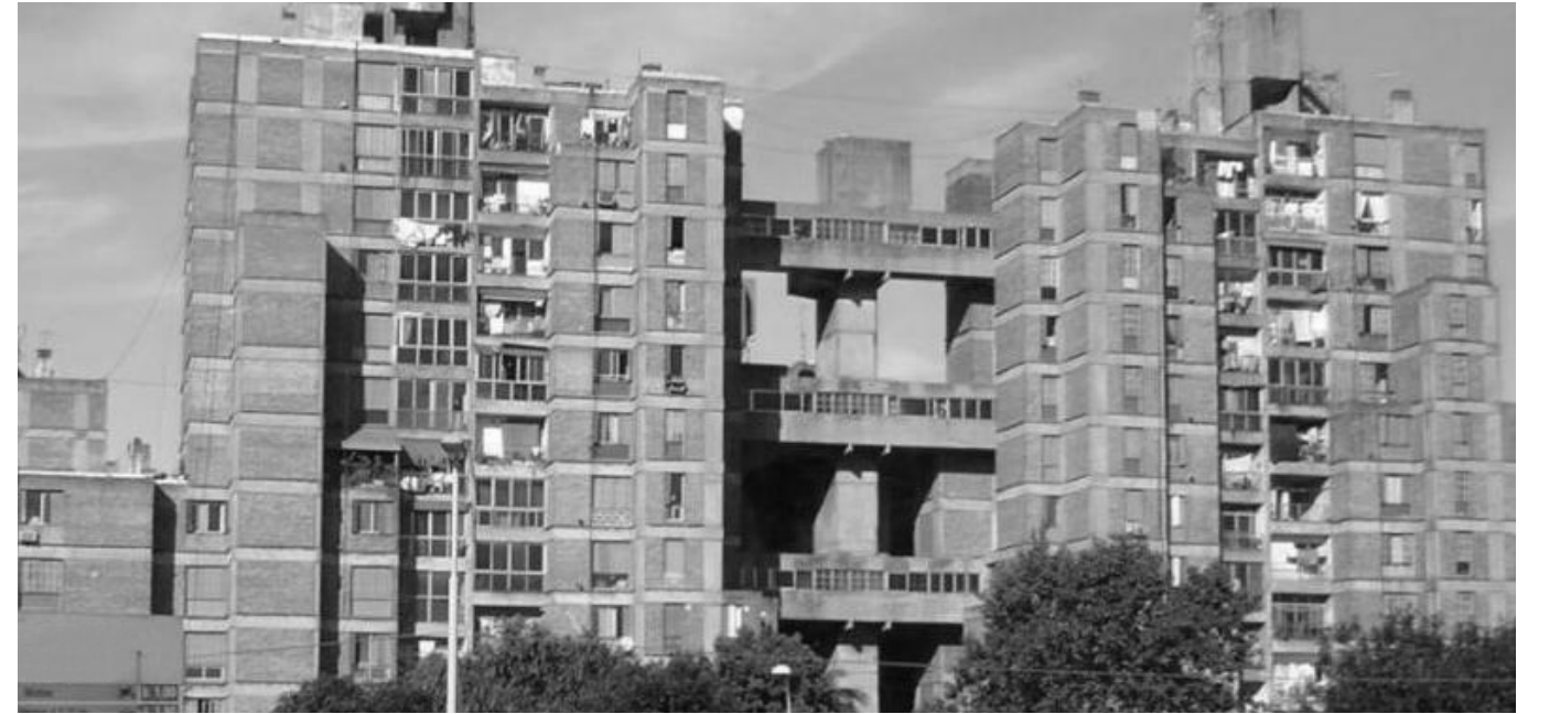
Vista de fachada
