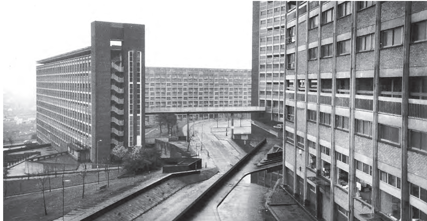
Vista de fachada y puente de conexión
