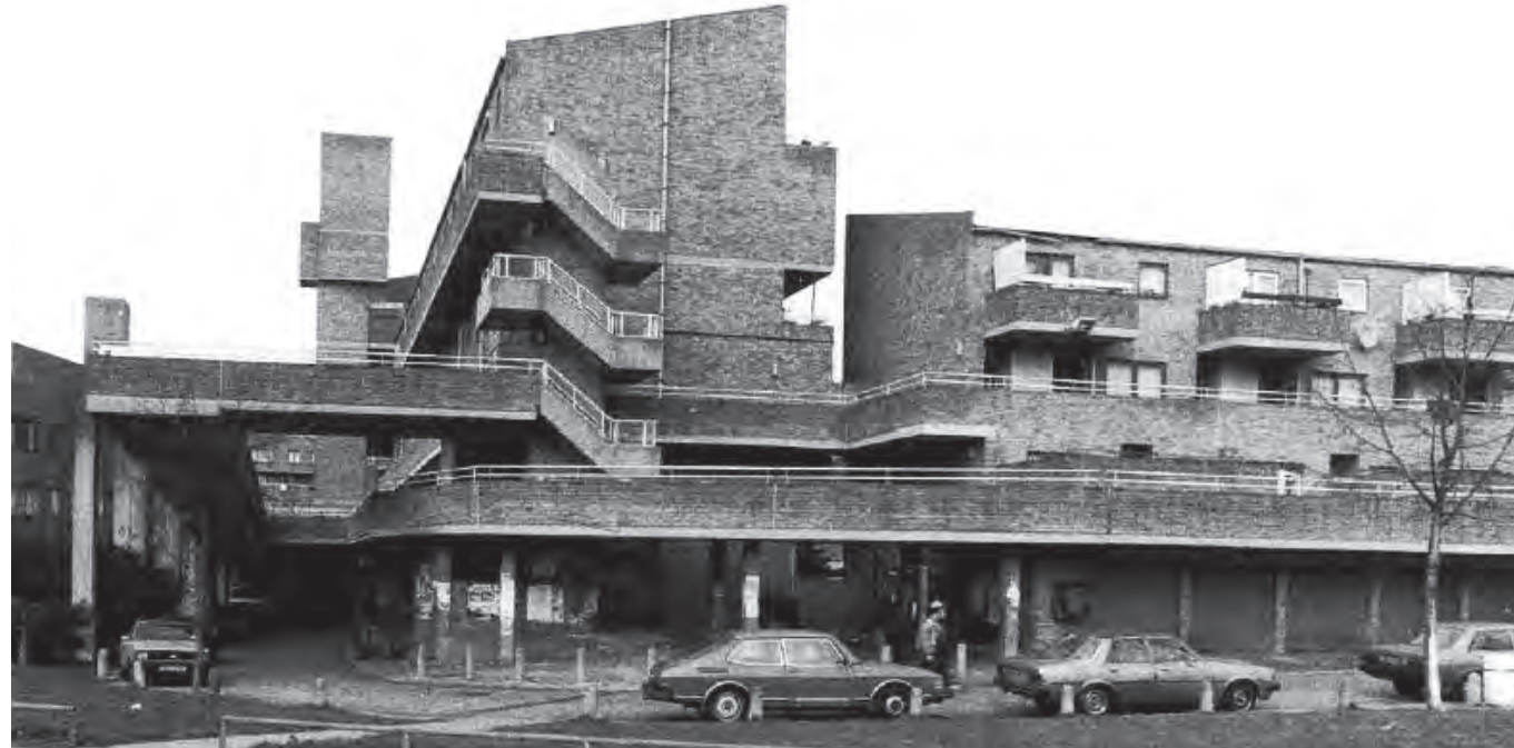
Vista de fachada
