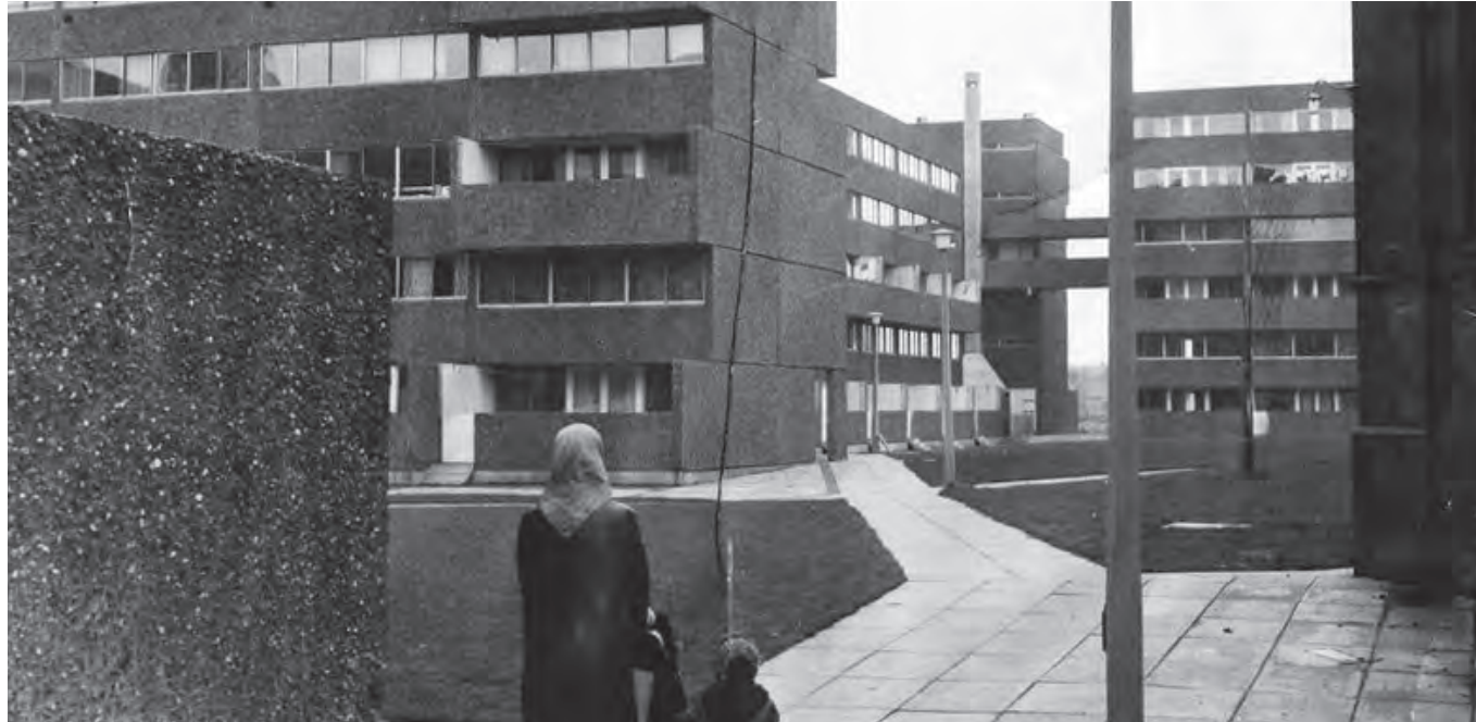
Vista de fachada
