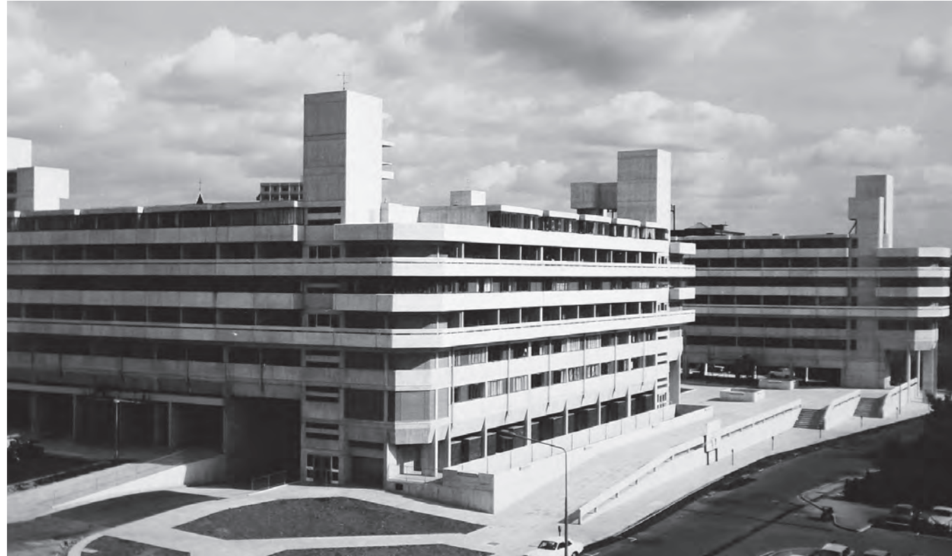
Vista de fachada
