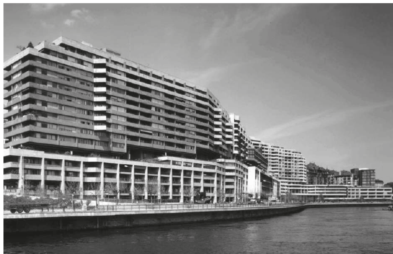
Vista de fachada
