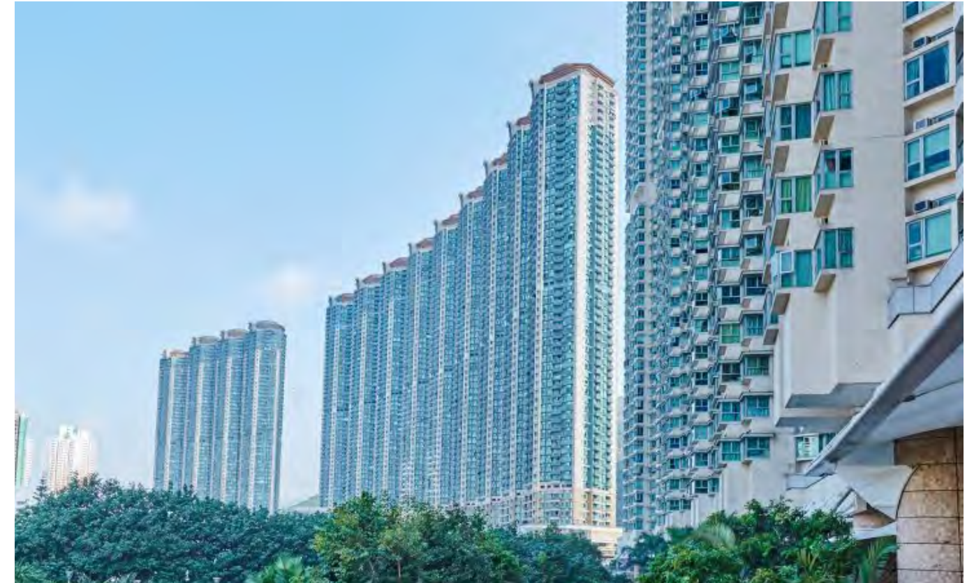
Vista de conjunto
