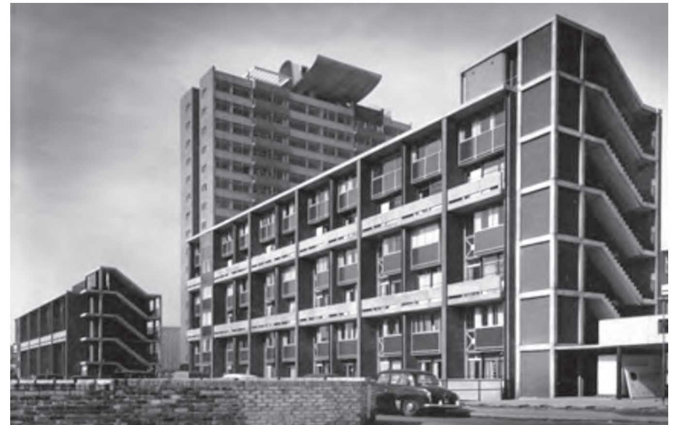
Vista de conjunto
