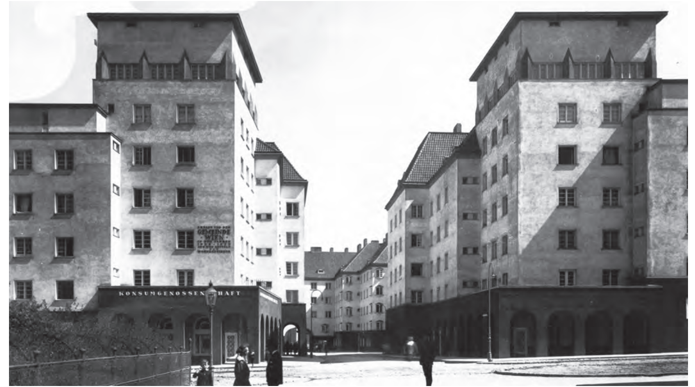
Vista de conjunto
