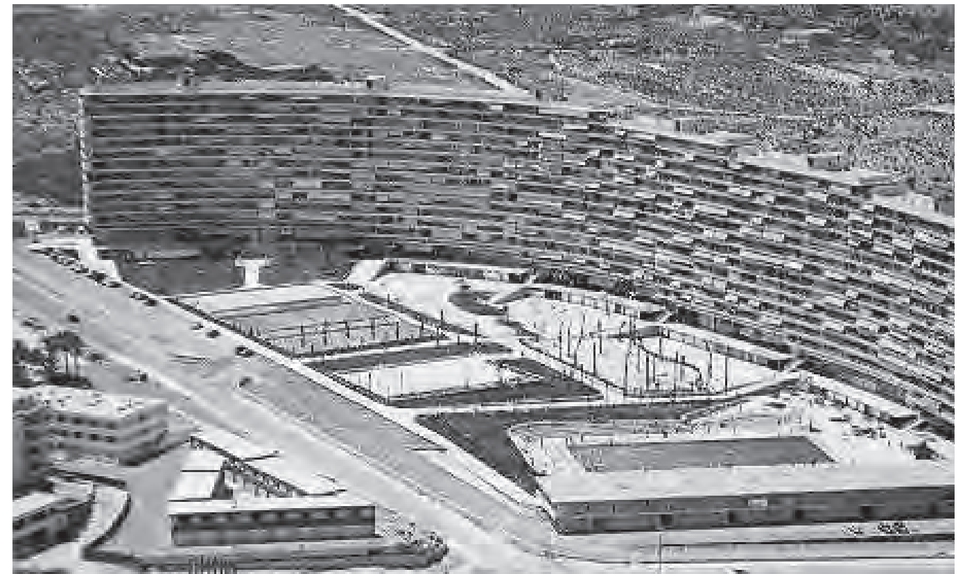
Vista de conjunto
