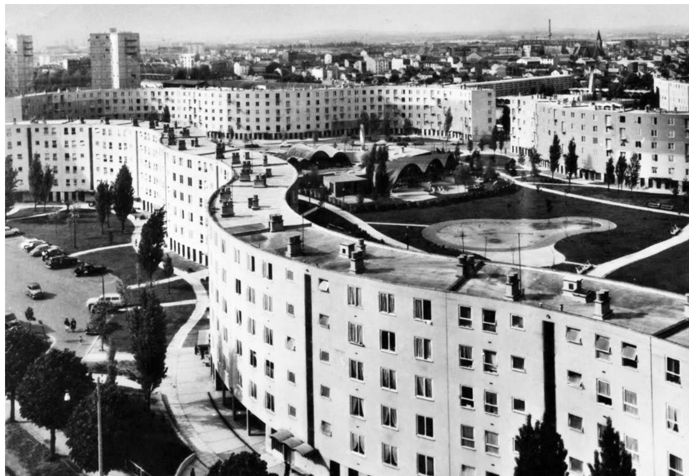
Vista de conjunto
