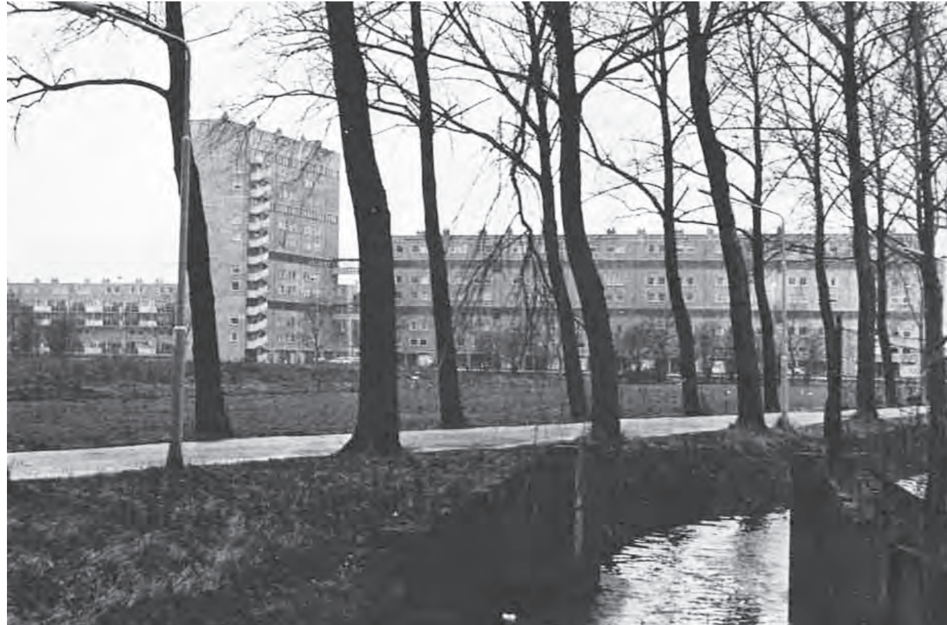
Vista de conjunto
