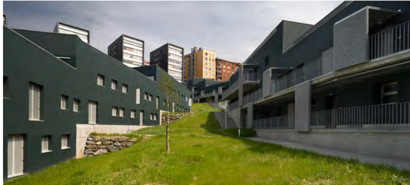
Vista de conjunto
