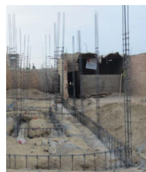
3.9. Fases de construcción de la vivienda del Convenio. (CESAL)
