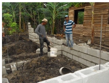
1.6 Proceso autoconstrucción. (ONGD Villa Nueva)
