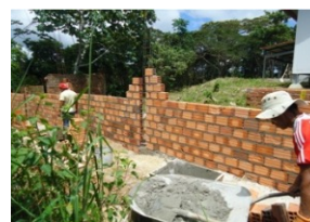
2.3. Proceso de construcción del Colegio Nuestra Señora de Loreto. (Equipo Técnico misioneros agustinos)
