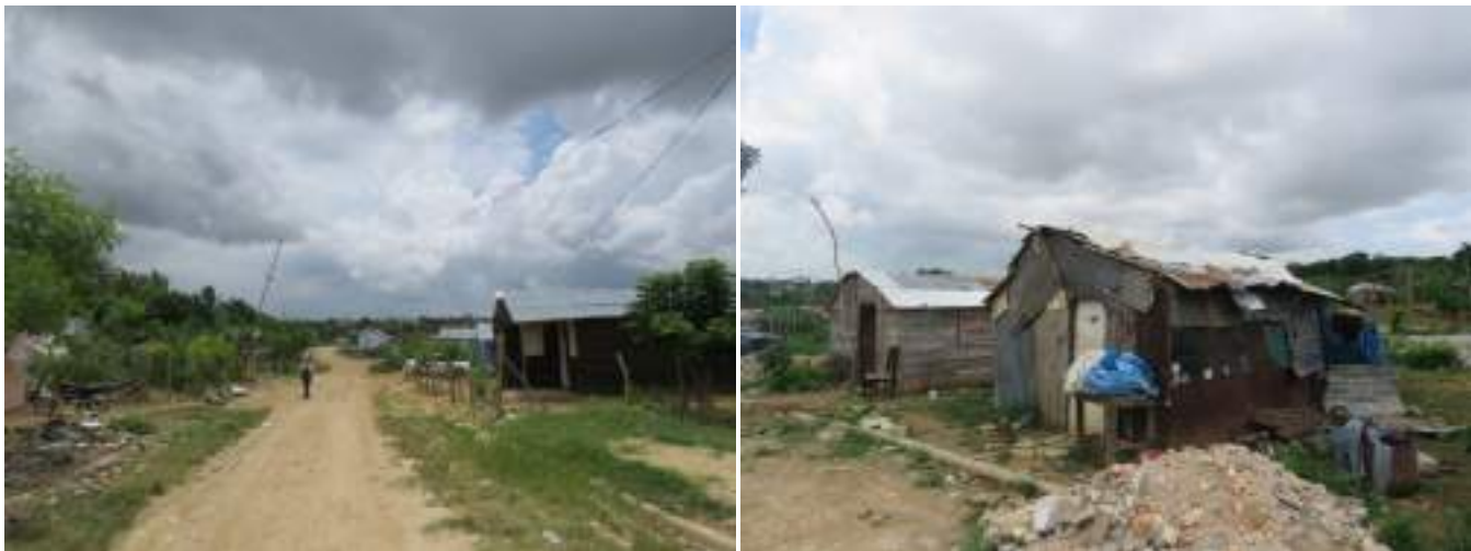
Viviendas del área de nuevo crecimiento. Calle entre la M115 y M117
