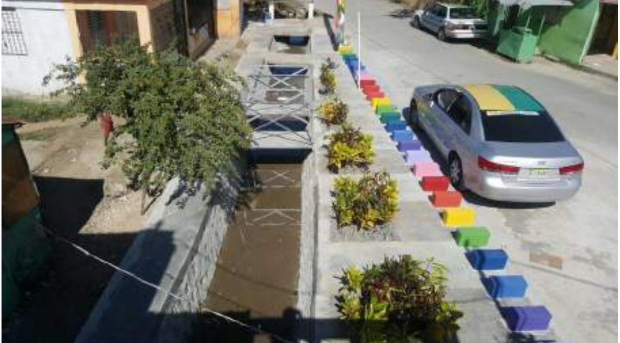
Resultado tramo de canalización cañada
