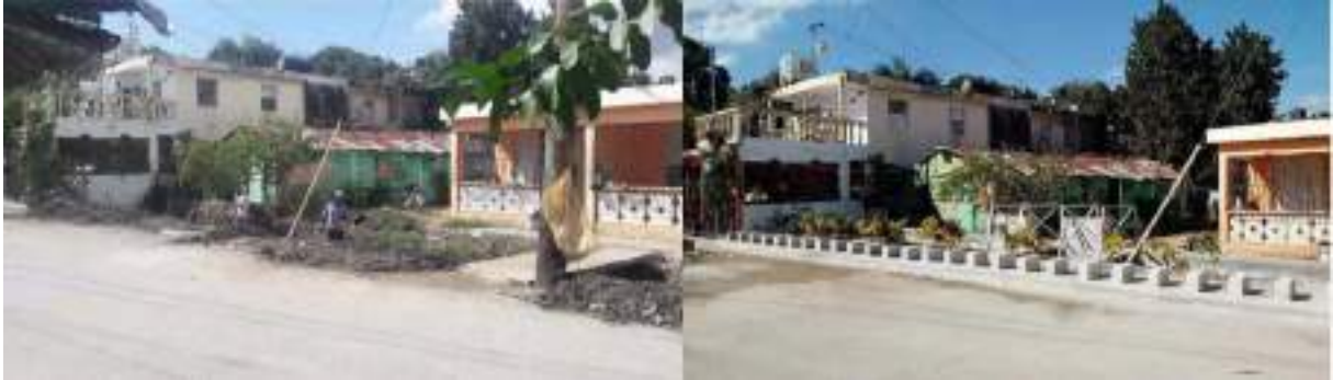
Obra y resultado final canalización cañada
