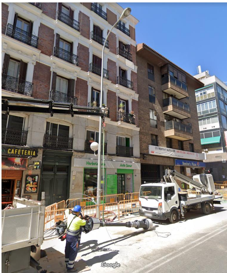
Figura 10.12 Momento en el que se procede a la retirada del equipo de medición de Embajadores, situado en la calle Atocha, por motivo de la sustitución de los postes de alumbrado público. Imagen captada por el servicio Street View de Google.
