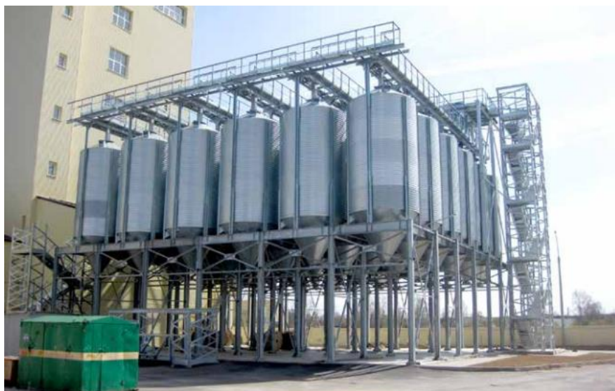
Figura 18: Silos para harinas Fuente: Silos Córdoba
