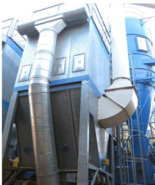
Figura 4: Silo con panel de venteo Fuente: Grupo Hunosa
