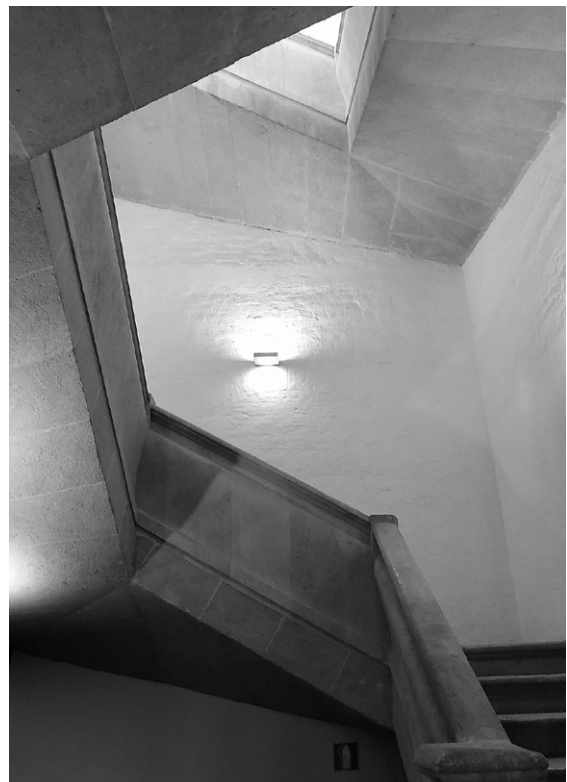
Dcha. Escalera de subida a cubiertas. Lonja de las Contrataciones. Sevilla. MIGUEL DE ZUMÁRRAGA.1605
