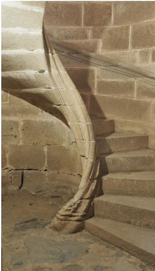
Caracol de mallorca. Moldura de remate de peldaño en disposición tangencial. Convento de San Benito. Alcántara.
