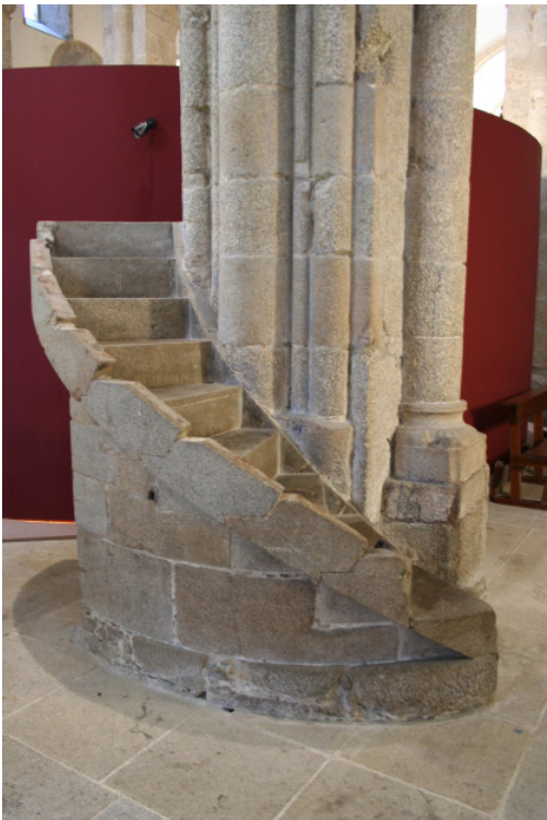
Iglesia Santo Domingo de Bonaval. Santiago de Compostela. Escalera volada de subida al púlpito.
