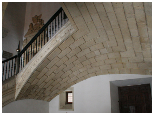
Escalera de la Real Chancillería de Granada. PEDRO MARÍN.1578
