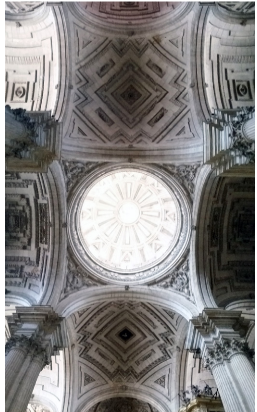
Dcha. Bóvedas con despiece en diagonal. Catedral de Jaén
