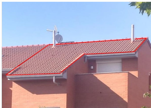
Figura 4.1. Foto del tejado Sur de la vivienda
