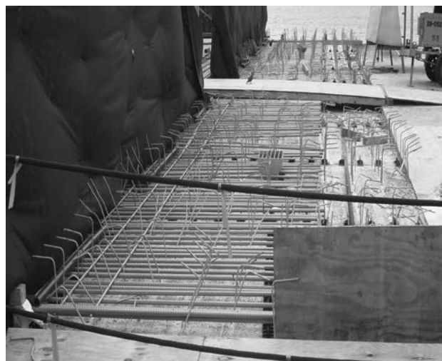
Figura 1. Barras corrugadas recubiertas de resina epoxi en el puente de los Dos Hermanos, San Juan de Puerto Rico
