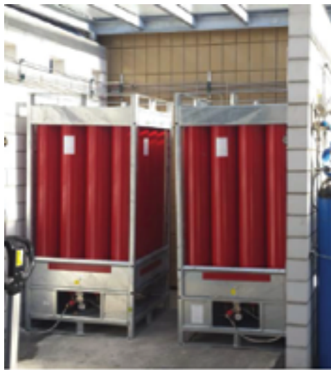
Figura 2.14: Depósitos de almacenamiento de hidrógeno en el laboratorio DESL, EPFL, Lausanne
