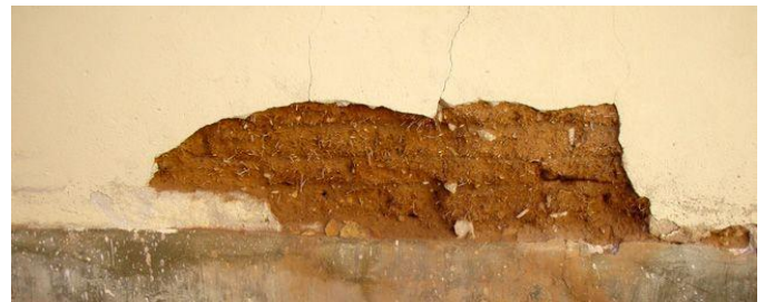
Imagen 67. Tapial de adobe con revoco exterior
