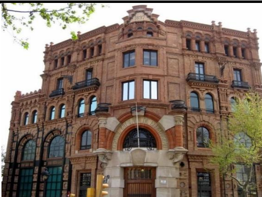
Imagen 70. Central catalana de electricidad (Barcelona)
