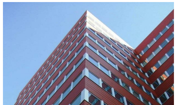
Imagen 46. Rehabilitación Magallanes 3, Madrid
