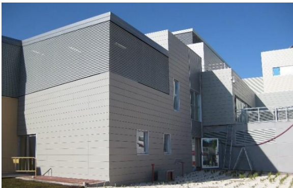
Imagen 47. Ejemplo de uso en edificio de carácter institucional
