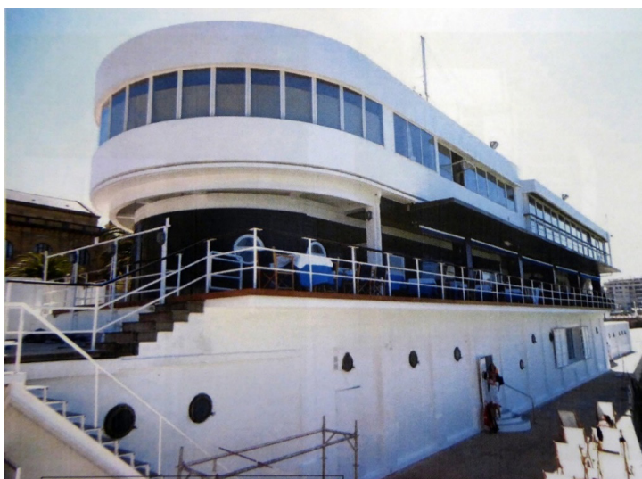
Figura 164. Fotografía del estado final tras la intervención de Íñigo Arizpereta Olano y Paola Vértiz de Luca, según final de obra. AK02-2012-000113. Archivo Urbanismo Ayuntamiento Donostia-San Sebastián
