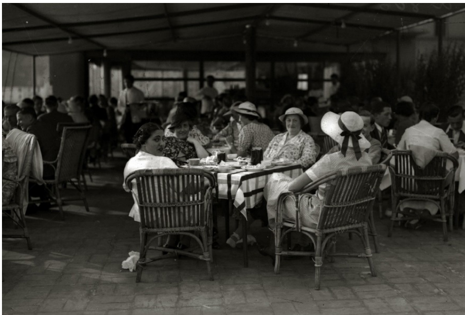
Figura 65. En la parte superior, fotografía del solado de la terraza de grandes piezas en 1929 y el baldosín que lo sustituyó. Fotografía 1935. Ricardo, Martín. 1929/1935 ID: 87837575/32327977. Archivo: Kutxa Fototeka
