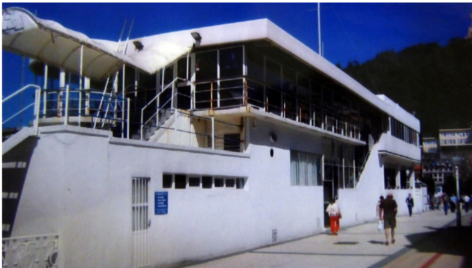
Figura 161. Estado antes de la reparación. 2006-OMLO-00547. Archivo Servicio de Urbanismo Ayuntamiento de Donostia-San Sebastián.
