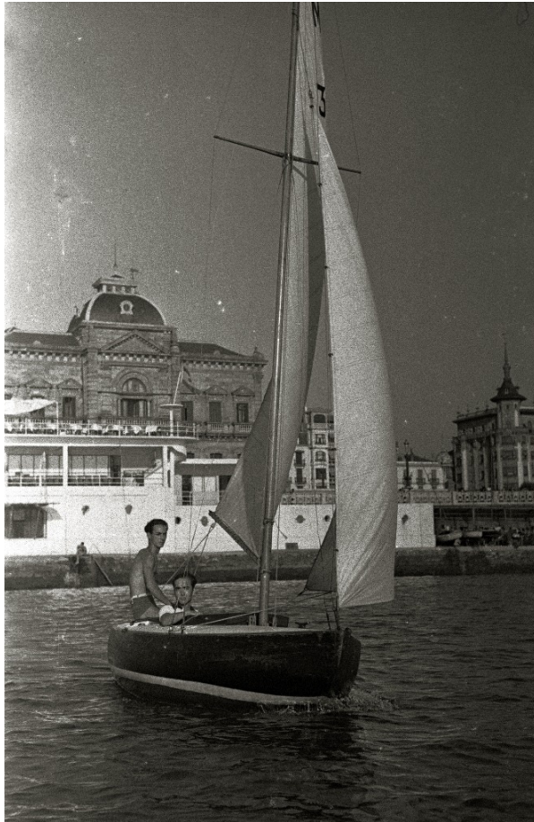
Figura 72. A la derecha, tras el edificio del Náutico, techumbre para el resguardo de embarcaciones. Martín, Vicente. 1941. ID: 95974989. Kutxa Fototeka
