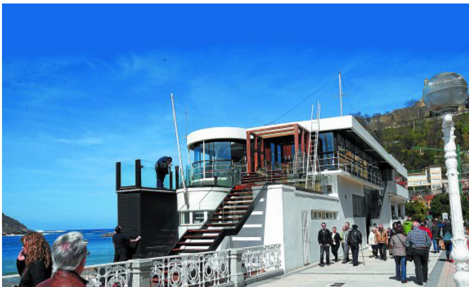
Figura 190. Elevador. Se sitúa en la planta baja cuando no es necesario su uso. Fotografía El Diario Vasco https://www.diariovasco.com/san-sebastian/201504/22/renovado-balcon-concha-20150415001146-v.html (Consultado 29 de diciembre 2018)
