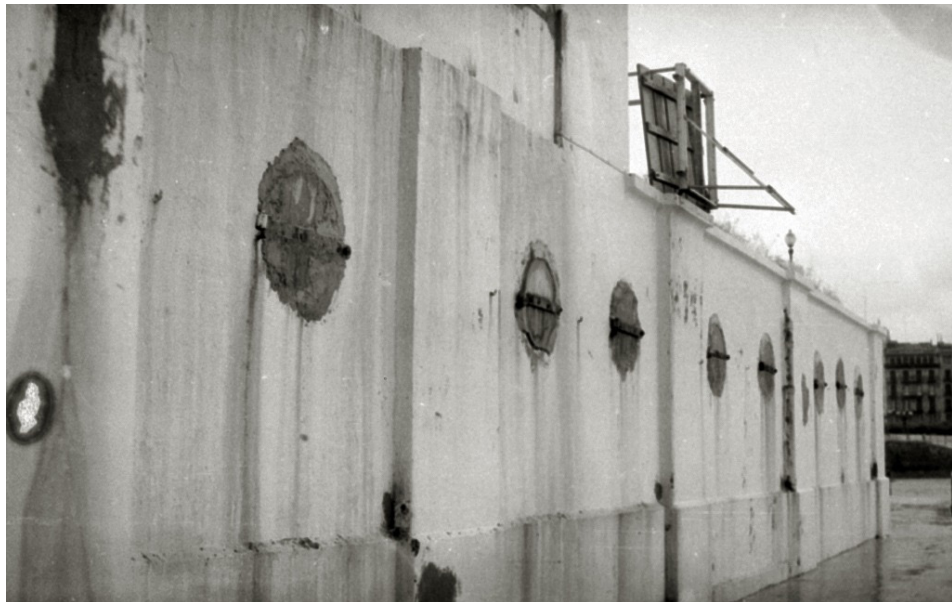
Figura 138. Detalle sellado con morteros de los huecos. Marí, Paco. 1950-1969. ID: 72698587. Kutxa Fototeka
