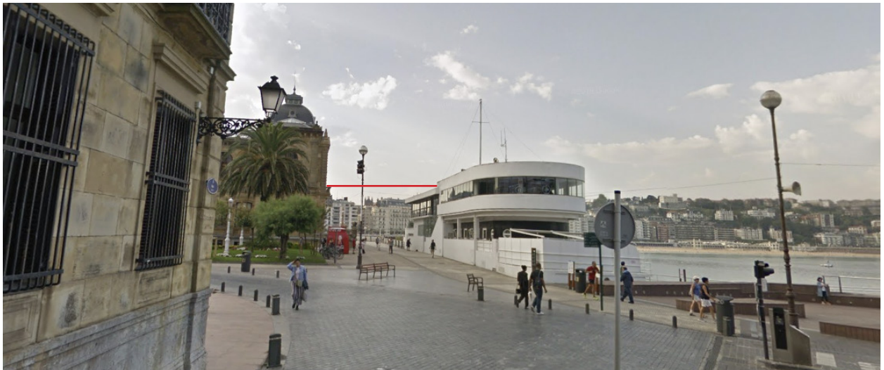
Figura 50. La altura original de la línea de cumbre, actualmente más alta que la construida en 1929 tras una intervención llevada a cabo en 1991, debió estar a una altura aproximada igual a la de los antepechos de las terrazas y miradores del Casino. Fotografía Google Maps
