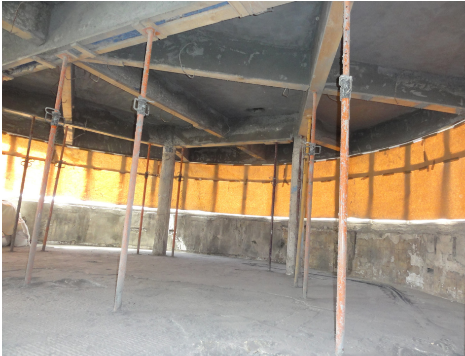
Figura 183. Vista de la intervención llevada a cabo en la estructura de la segunda planta. 2013. Miguel Ángel Ruano
