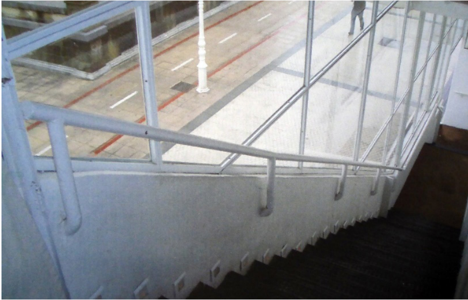
Figura 168. Escalera antes de la colocación del Salva-escaleras. Fotografía 2009-OMLO-00250. Archivo Servicio de Urbanismo Ayuntamiento de Donostia-San Sebastián.
