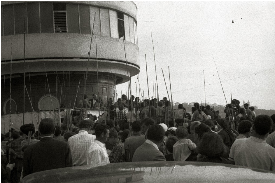
Figura 96. Frente curvo de la planta baja del real Club Náutico de San Sebastián sin refuerzo estructural. Marí, Paco. 1967 ID: 54657335.1970s. Kutxa Fototeka
