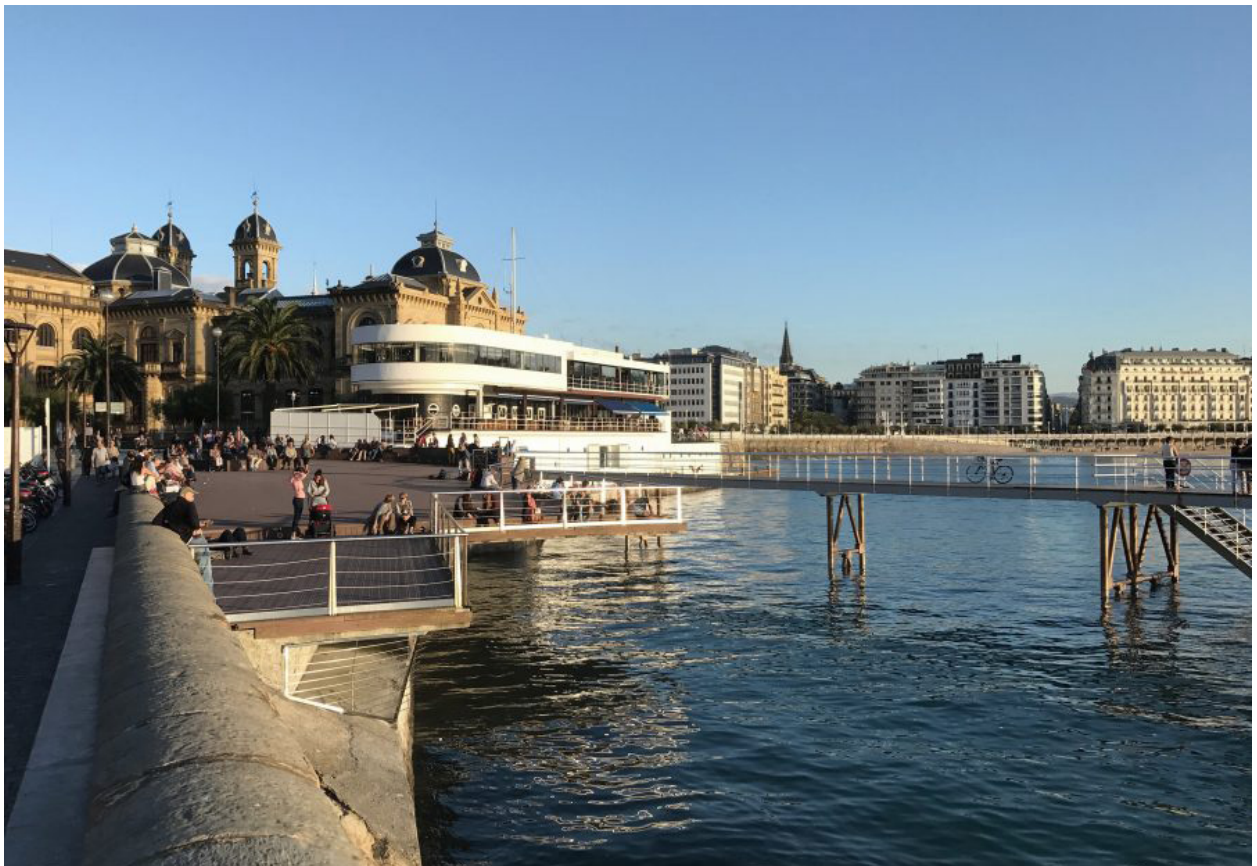
Figura 171. Antes y después de la ejecución del Mirador del Náutico. Gílder Ingenieros
