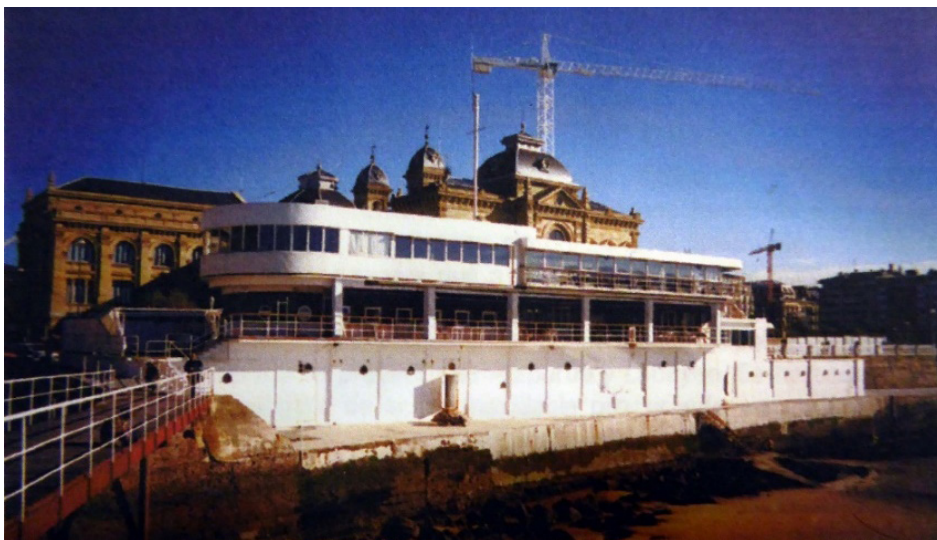
Figura 155. Estado inicial y fotomontaje con el estado final tras las actuaciones previstas en el proyecto de Pablo Samaniego Arocena y Francisco Zuzunaga Camargo. 2002-OMLO-01265. Archivo Servicio de Urbanismo Ayuntamiento de Donostia-San Sebastián.
