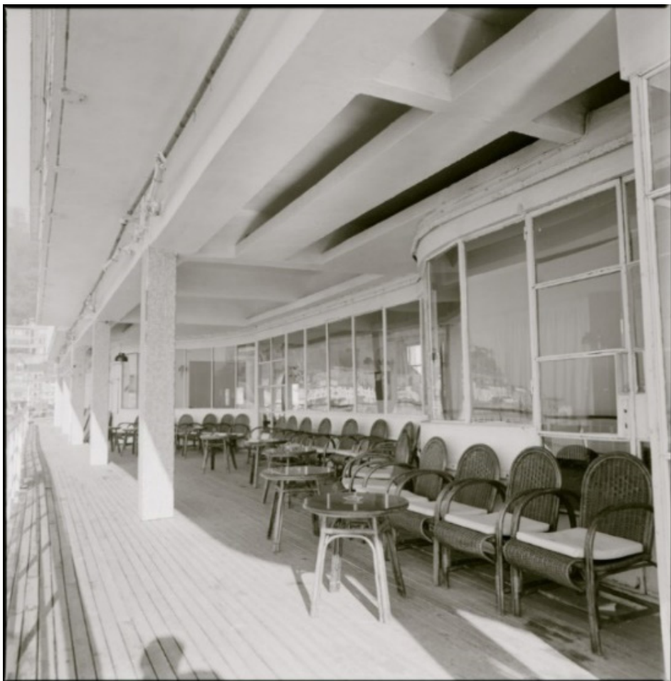
Figura 76. En primer plano, cerramiento alabeado creado tras la construcción de las taquillas en 1947. El cierre afectó a todo el corredor abierto que pasaba entre la sala de juntas de la dirección del Náutico y la escalera de caracol en la fachada hacia la bahía. El cierre creó un paso entre la entrada posterior del Náutico, en el que se dispuso la taquilla construida en 1947, y el hall del edificio en planta baja, ahora convertido en bar. Charola, Víctor. S/F. ID: 86920469. Kutxa Fototeka
