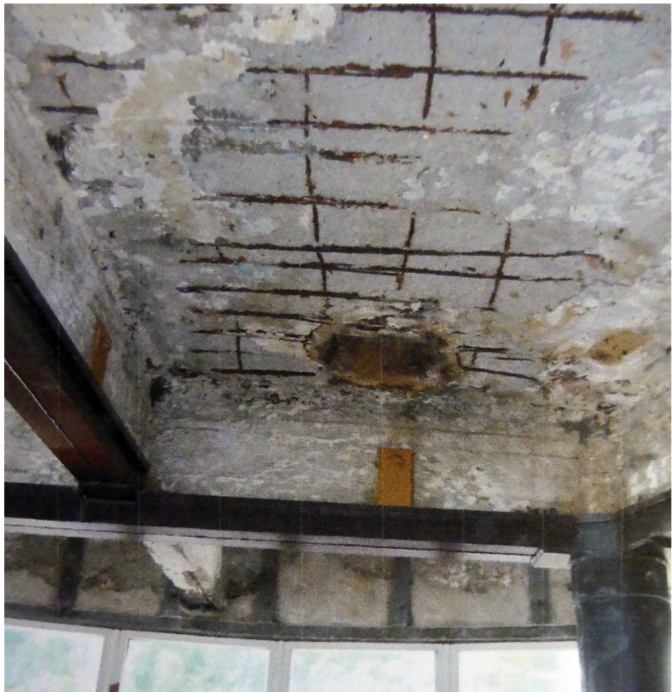
Figura 176. Paso de conductos abandonados. Se aprecia la estructura metálica que sujeta las ventanas apoyándose en la de hormigón. 2013. Beatriz Gil Rodríguez.
