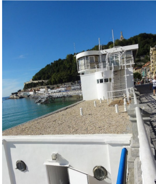
Figura 109. Ventilaciones realizadas sobre el cuarto de bañistas en 1986. Septiembre de 2013. Miguel Ángel Ruano Hernansanz
