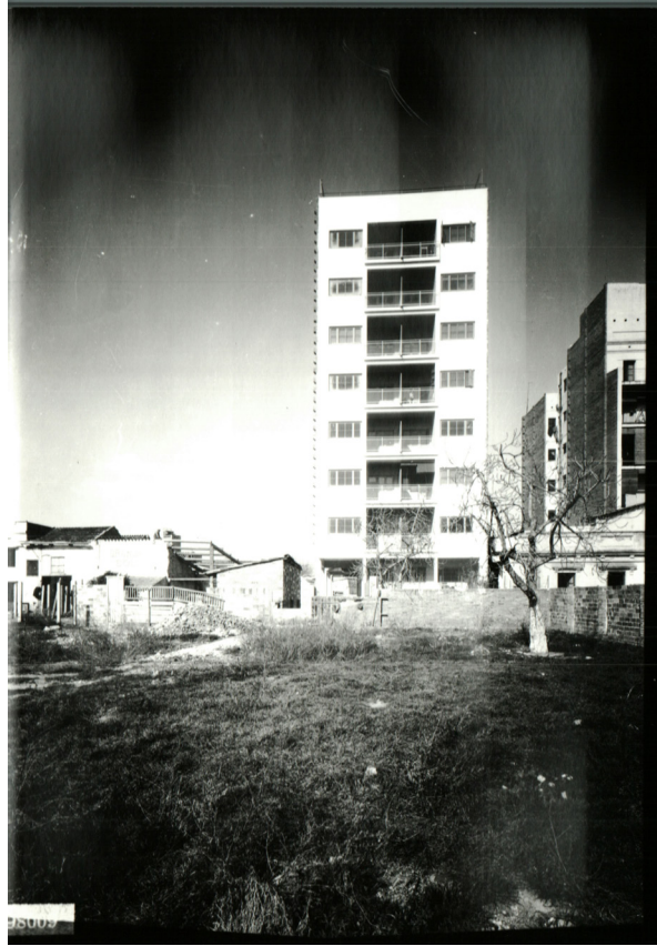
Figura 26. Edificio de Roselló 36. Fachada interior de manzana (No identificada por el Archivo). 1930. Fondo GATEPAC. Caja 1.1.C.2.K.4 Fotografías de Margaret Michaelis. 60121. Arxiu Fotogràfic. Ajuntament de Barcelona.
