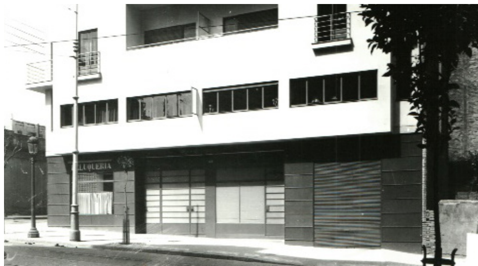
Figura 68. Detalle planta baja Muntaner. Nótese que el hueco de escaparate ocupaba originalmente 4 franjas del acabado de fachada en planta baja, y no 3, como señaló en su proyecto Josep María Linares Domenech. Arxiu Municipal del Districte de Sarrià Sant Gervasi (Barcelona)
