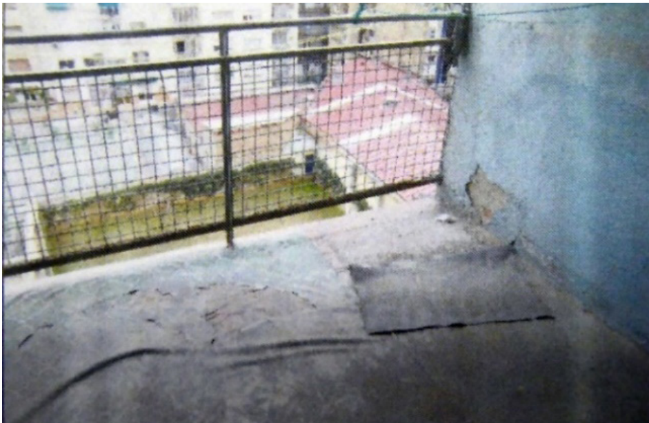
Figura 63. Detalle de una de las terrazas. Aún mantenía color original. Sin especificar a cuál corresponde en el informe. De Ángel Castrel, Daniel. Memoria del proyecto. Expediente 02.2007L02734 Arxiu Municipal del Eixample
