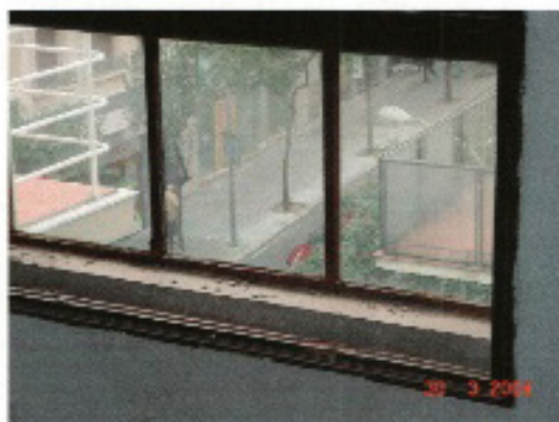
FINESTRA EXTERIOR DOBLA ALÇADA DUPLEX A RESTAURAR.
