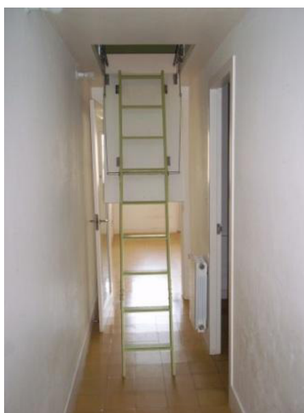
Figura 40. El altillo que aparece en la fotografía correspondería a un falso techo ganado rebajando la altura libre del pasillo. Vivienda sin identificar de Roselló 36. Fotografía facilitada por Fincas Lluria
