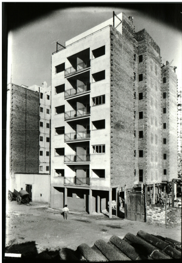
Figura 24. Construcción edificio de Roselló 36. Aún se mantienen algunas vigas de la estructura de acero a la vista. 1930. Fondo GATEPAC. Caja 1.1.C.2.K.4 Fotografías de Margaret Michaelis. 60067. Arxiu Fotogràfic. Ajuntament de Barcelona.
