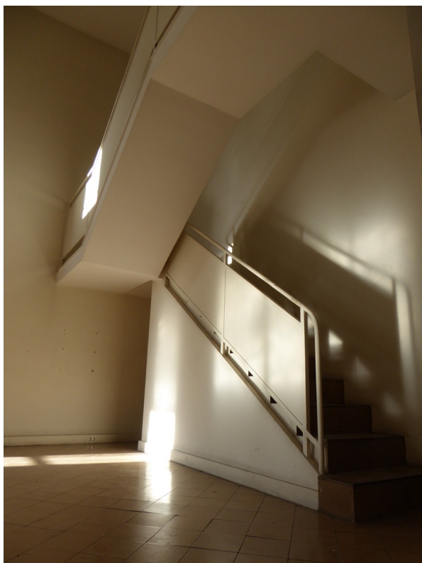
Figura 78. Detalle del solado original. Estado en 2015. Fotografía Miguel A. Ruano
