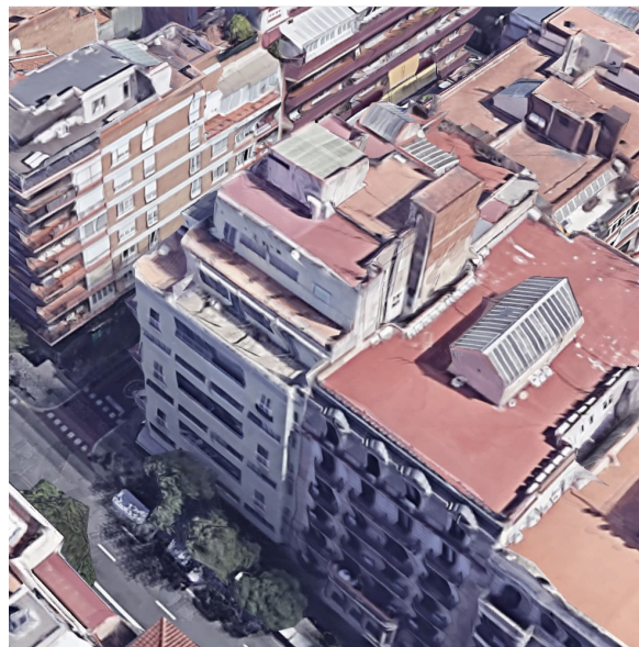
Figura 98. Estado del patio de luces en la medianería de la calle Muntaner en 2020. Google Maps.
