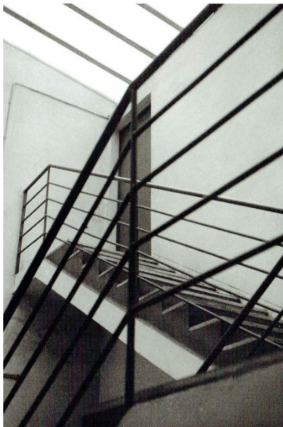
Figura 48. Fotografía de la salida a las terrazas sobre la planta ático. Fotografía J.M. Aizpurua. (Sanz Esquide, 2004:102)
