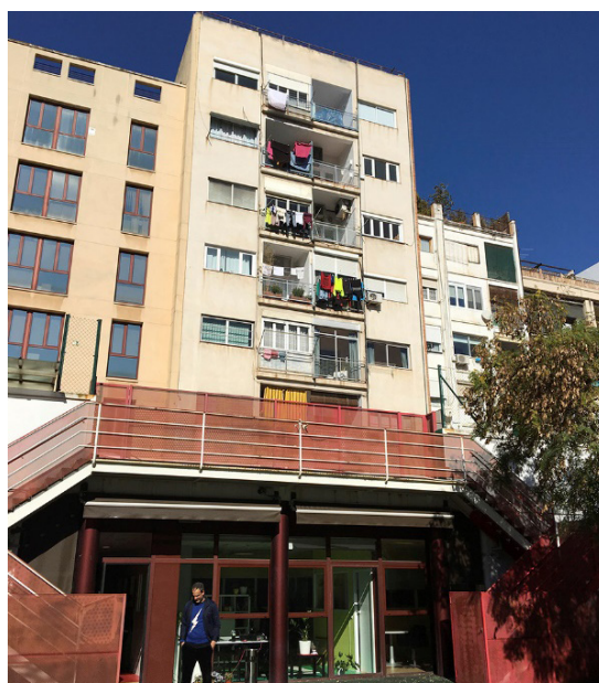
Figura 70. Fachada posterior. Estado en 2017. Fotografía Taidoplus
