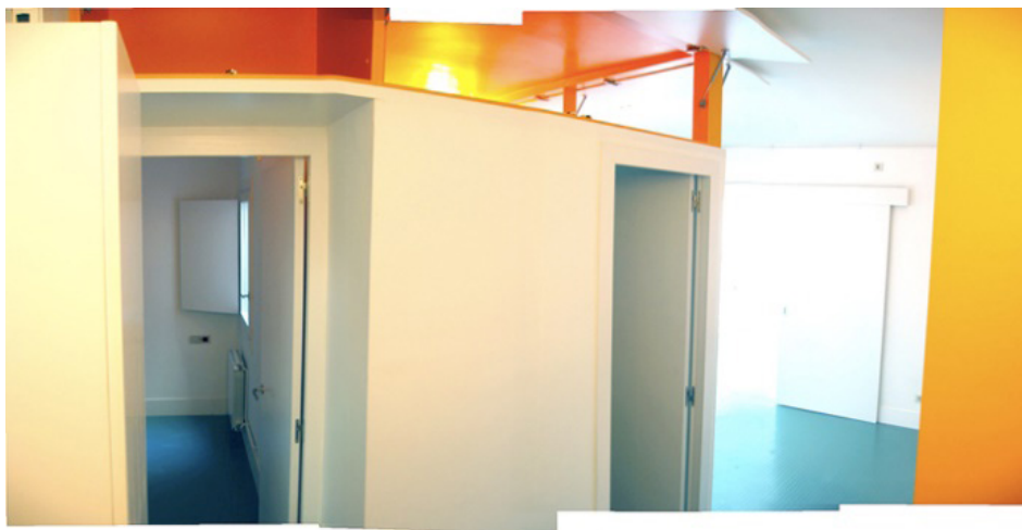
Figura 47. Obsérvese que el baño aparece adelantando sobre acceso a la habitación. La cubierta del baño se habría bajado para aprovecharlo para almacenamiento de objetos. Ático Dcha. Roselló 36. Fotografía facilitada por Fincas Lluria
