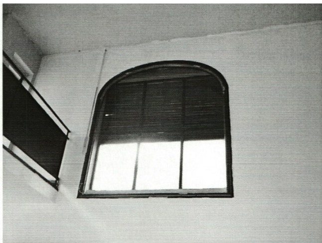
Se recuperará la forma original de esta ventana, que fue redondeada en las obras anteriores. Nuestra intervención dejará la ventana rectangular.
