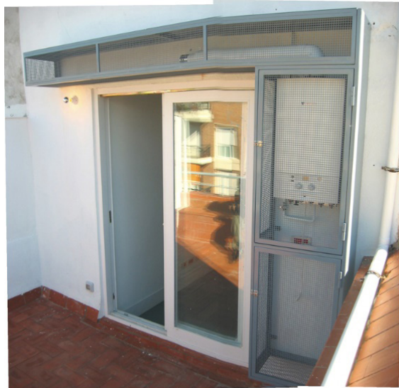
Figura 45. Obsérvese que la terraza no corresponde con la terraza tipo de Roselló 36. Ático Dcha. Roselló 36. Fotografía facilitada por Fincas Lluria
