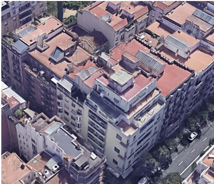
Figura 57. Vista 3D del edificio en la actualidad. www.google.com/maps Consultado 12 de febrero de 2020
