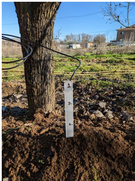
Ilustración 16 Instalación final del sensor de humedad
