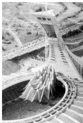
Figura 4.1.7: Cubierta retráctil del estadio olímpico de Montreal, 1976, Roger Taillibert.
