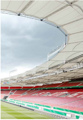
Figura 2.17: PES/PVC + TiO 2 . Cubierta compuesta por una membrana textil de poliéster recubierta de PVC y con acabado de TiO 2 .
