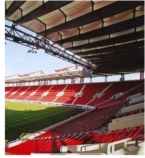
Figura 2.16: PES/PVDF. Cubierta compuesta por una membrana textil de poliéster recubierta de PVDF (Kynar).
