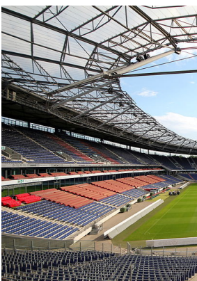
Figura 2.19: ETFE. Cubierta compuesta por una lámina textil de ETFE de una sola capa.
