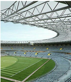
Figura 2.18: GLASS/PTFE + TiO 2 . Cubierta compuesta por una membrana textil de fibra de vidrio recubierta de PTFE (teflón) y con acabado de TiO 2 .
