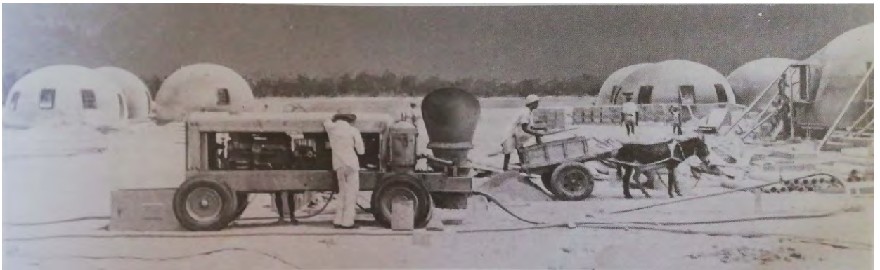
Imagen 55 Obras de construcción en Karachi, Pakistán
