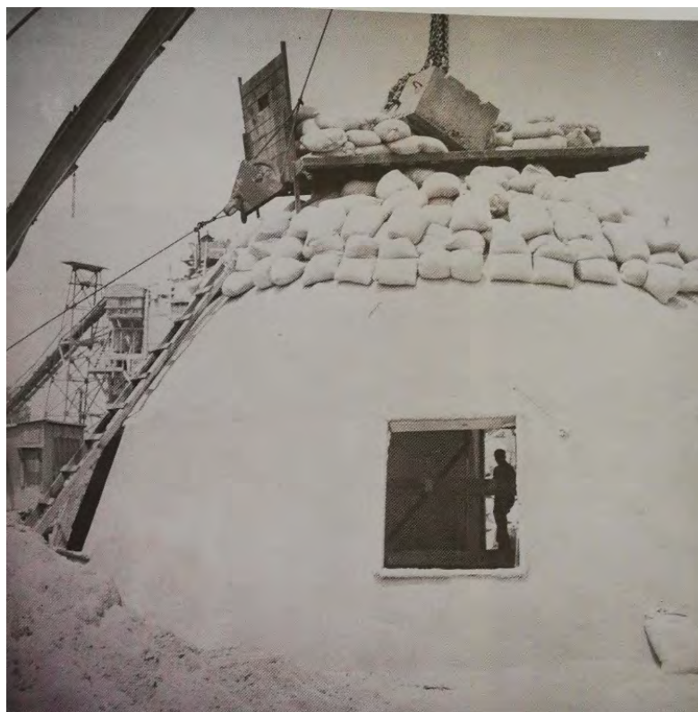
Imagen 50 Comprobación de resistencia de la estructura
