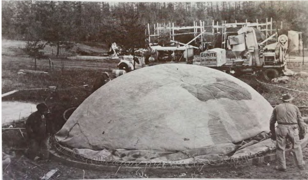
Imagen 47 Colocación e inflado del globo
