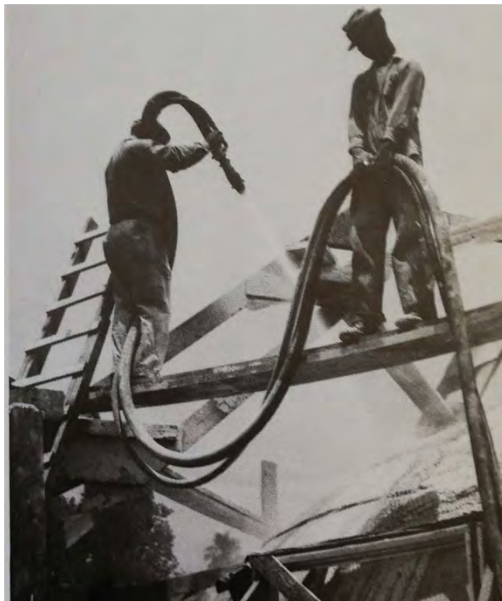
Imagen 49 Gunitado del hormigón
