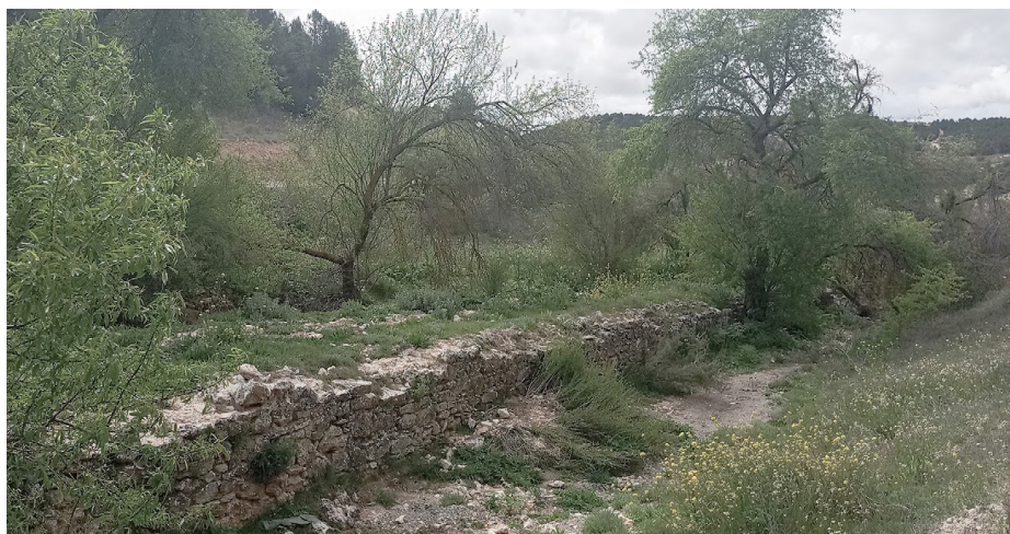
Fig. 2.1.06. AUTORÍA PROPIA, 2022. Muro de contención en Aljibejo para la protección del sistema frente a las aguas pluviales. [Fotografía].
