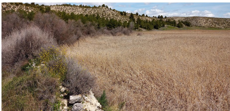
Fig 2.3.31. AUTORÍA PROPIA, 2022. Murallón de la presa visto desde arriba . [Fotografía].
