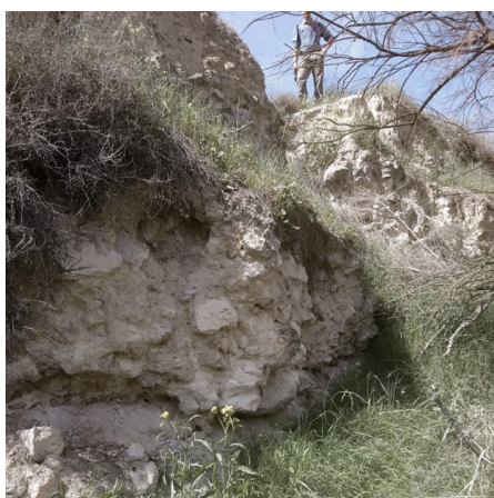
Fig. 2.3.28. (Izquierda) AUTORÍA PROPIA, 2022. Sillares en ruinas de la presa. [Fotografía].
