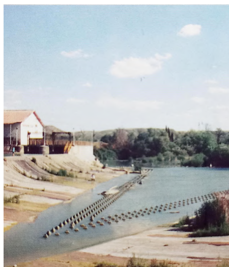
Fig. 2.3.33. (Izquierda) AUTORÍA PROPIA, 2022. Vista aérea de la presa de Buena Mesón. [Ortofoto]. Documento realizado a partir del Plan Nacional de Ortofotografía Aérea (PNOA) del 2021 del Instituto Geográfico Nacional.
